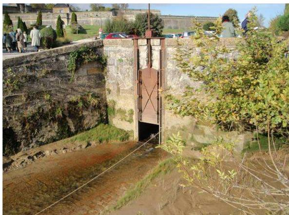
Un ouvrage de 9 mètres de large sur 4,30 mètres environ équipé d'une pelle à crémaillère de taille : 2,65 mètres de haut sur 1 mètre de large.
