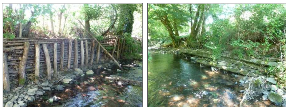
Figure 19.1 et 20.2 : Protections de berge (poteaux électrique et ensemble pieux / branches)
