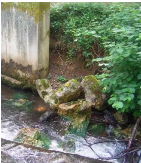
Figure 18 : Mise en mouvement des enrochements et affouillement des culées du pont à l'aval du passage à gué
