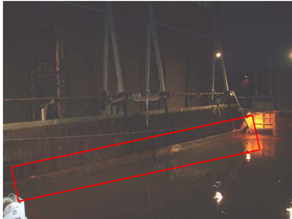
Photo 4 : Masque plein de surface (tôles fixées sur le râteau du dégrilleur de Pointis)
