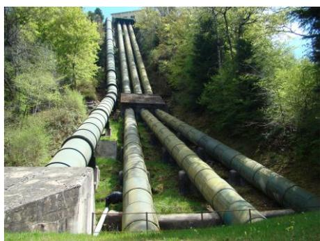
Conduites forcées dérivant les écoulements vers l'usine de Coindre
