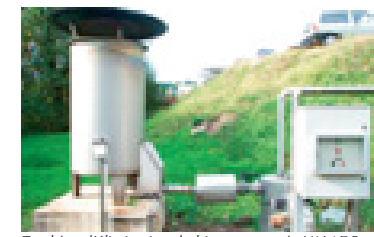
Torçère d'élimination du biogaz en excès VALADE
