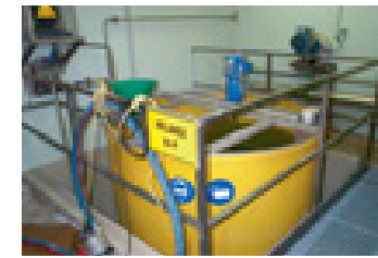
Parfois, l'ajout de nutriments (Phosphore et azote) est nécessaire..., mais il n'est pas systématique - Conserverie VALADE
