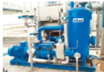
Surpresseur fonctionnant au biogaz utilisé pour le décollement des boues sur lits fixés.
