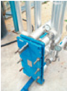
Échangeur de chaleur à plaques, eau chaude/effluents entrants - Confiturerie MATERNE
