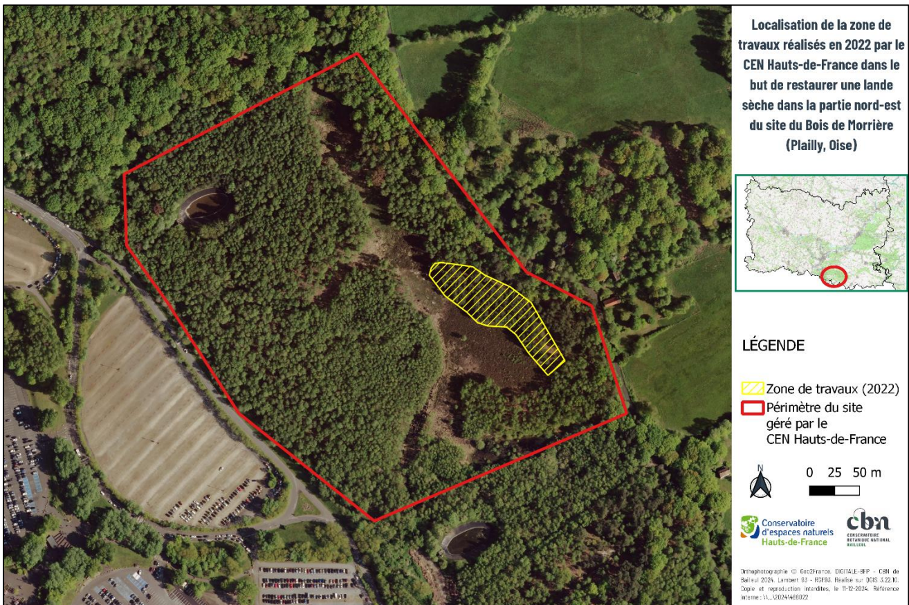
Figure 1 - Localisation de la zone ayant fait l'objet de travaux de déboisement, d'essouchage et de décapage en 2022 au sein de l'entité située au nord-est du Bois de Morrière (Plailly, Oise)
