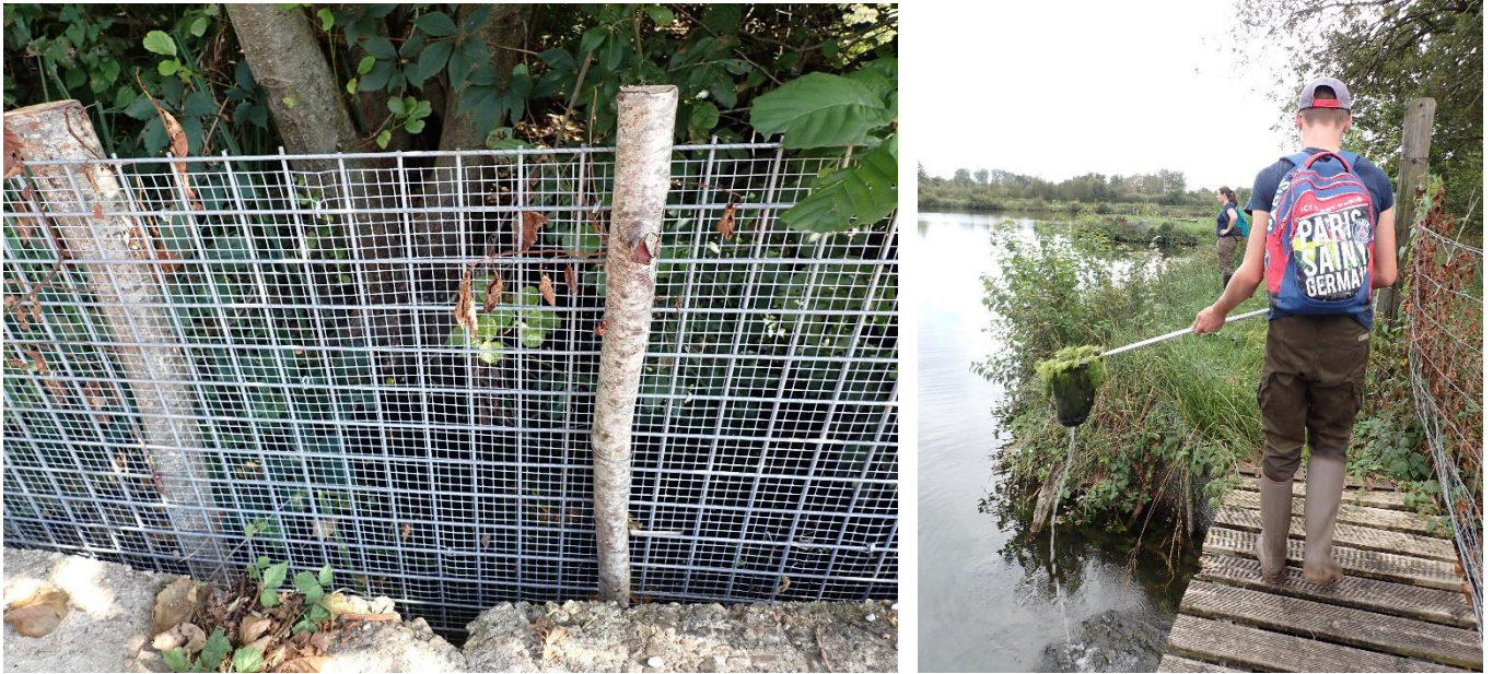
Figure 1 Détail d'une grille au niveau d'une connexion hydraulique (à gauche) et ramassage manuel des fragments d'individus stagnant devant cette grille (à droite)
