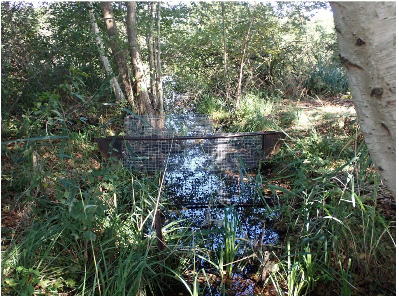
Figure 2 Vue d'ensemble d'un barrage constitué de grilles de différents maillages au niveau d'une connexion hydraulique entre deux lots d'étangs
