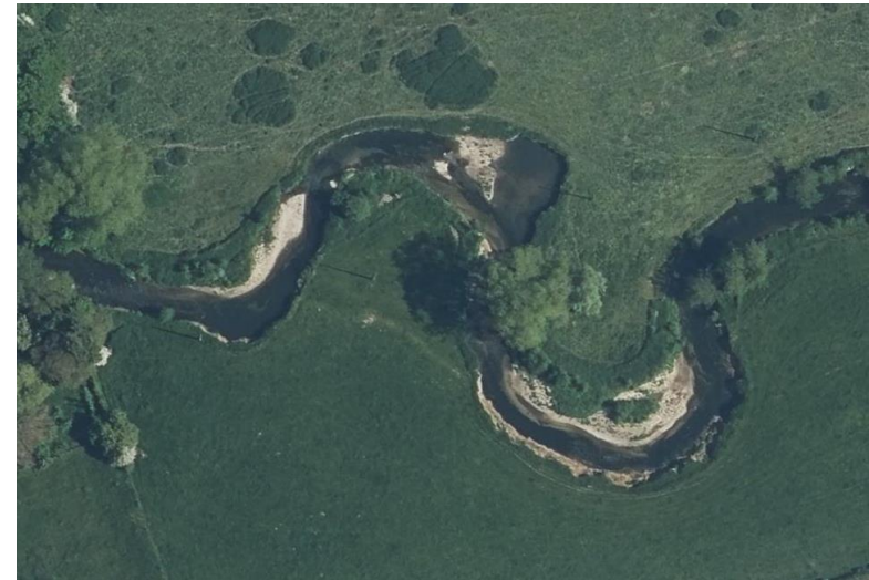
Photos quatre ans après travaux
