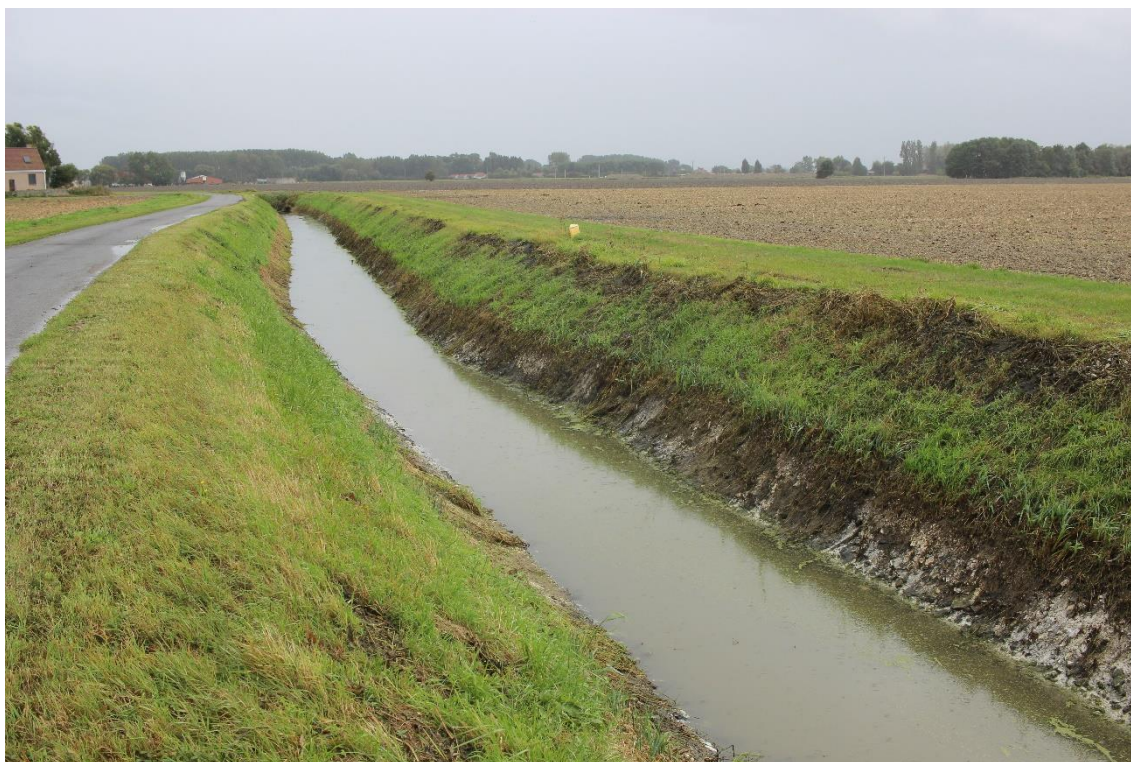
Figure 9 - Watergang et bande enherbée associée (à droite de la voie d'eau)
