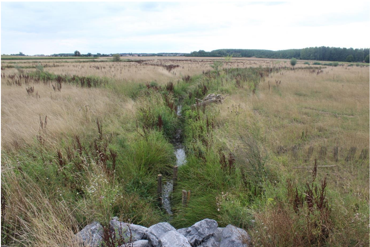
La ZEC de Drumez vue du talus créé à l'est du site, Attiches et Mons-en-Pévèle (C. MONEIN, 2018)
