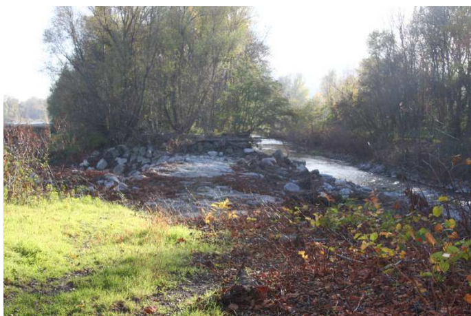
Vue du déversoir depuis l'amont.
