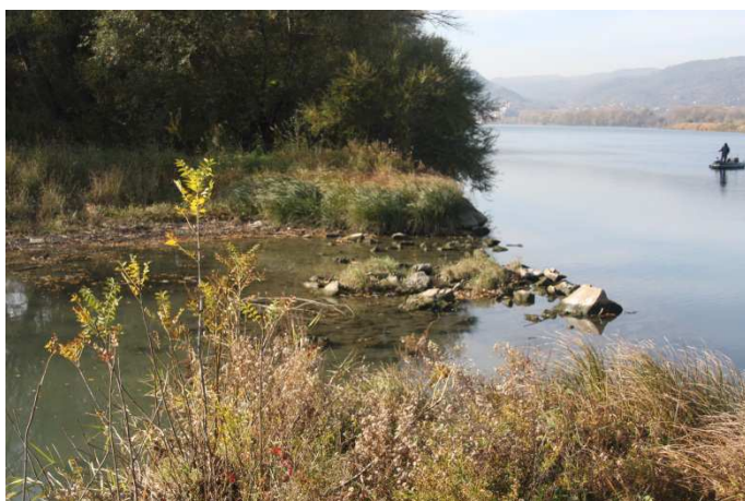
Brèche à l'amont du casier n°4.
