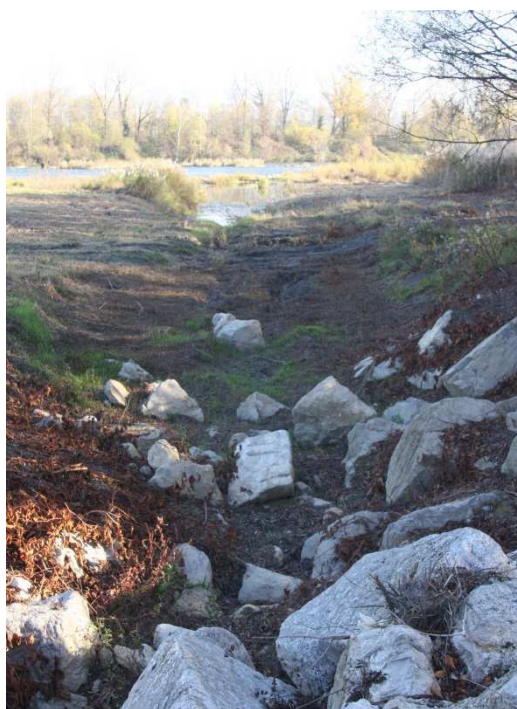
Thalweg à l'aval du déversoir (côté Vieux-Rhône).
