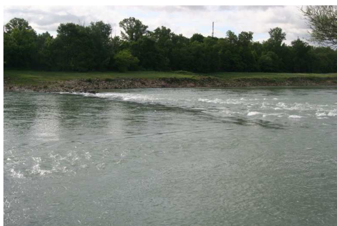
Gazoduc sous fluvial au PK 6.3
