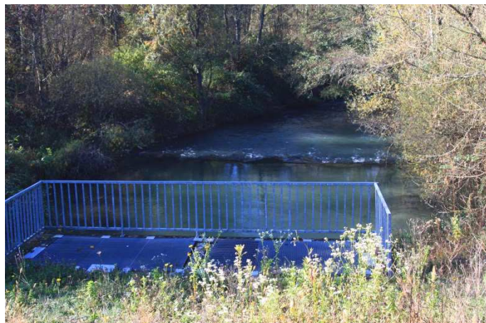
Prise d'eau de la lône de la Fronde.
