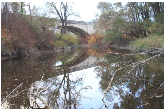
Lône à l'amont du pont (vue vers l'aval).
