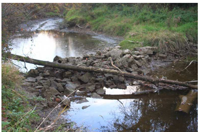
Traverse barrant la lône.
