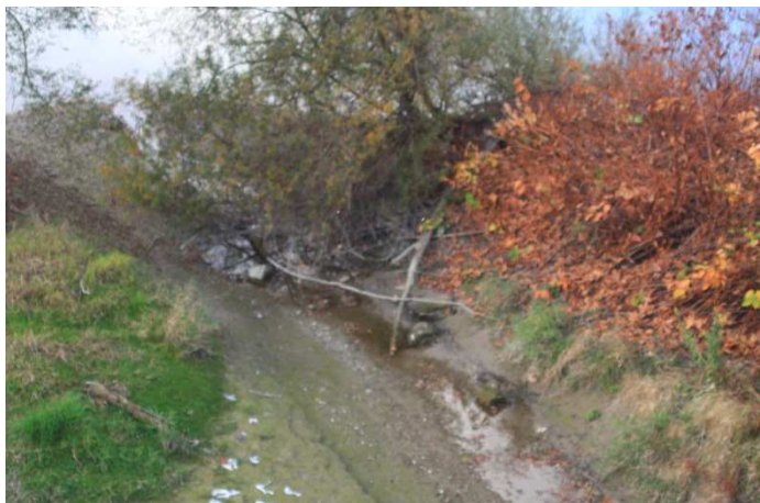
Connexion de la lône au Rhône.
