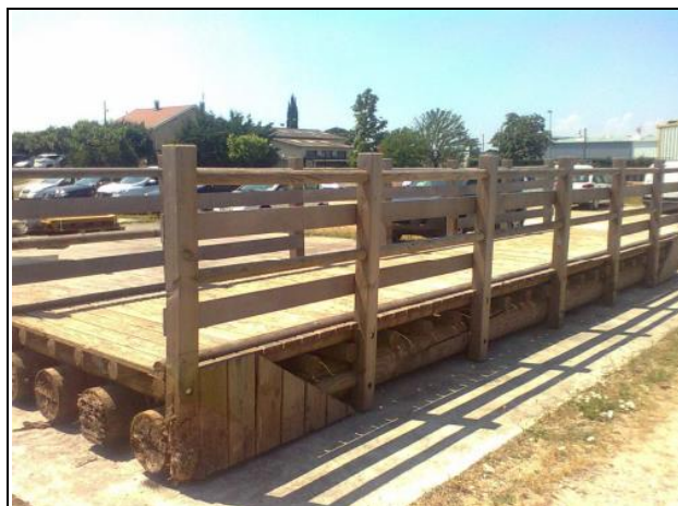
Figure 52 : Passerelle piétonne récupérée de toute pièce par la CAVRA
