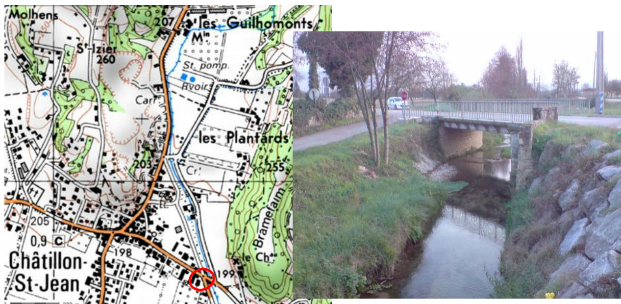
Figure 40 : Localisation du pont de la RD 112 à Châtillon-St-Jean
