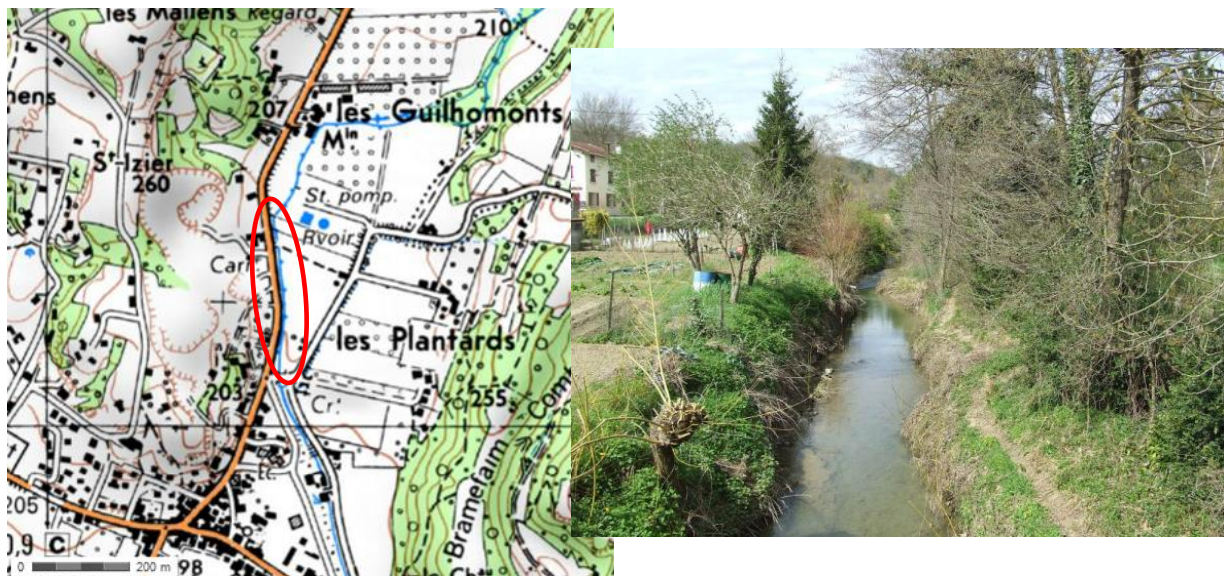
Figure 35 : Localisation de la Joyeuse en amont du Pont des Plantards
