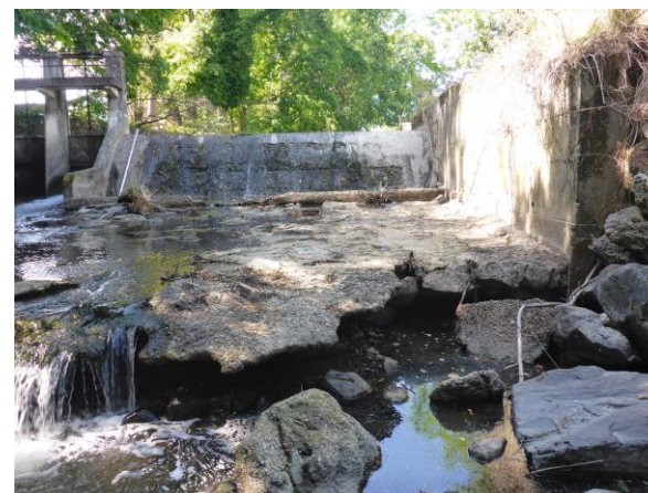
Seuil, radier et bajoyer rive gauche
