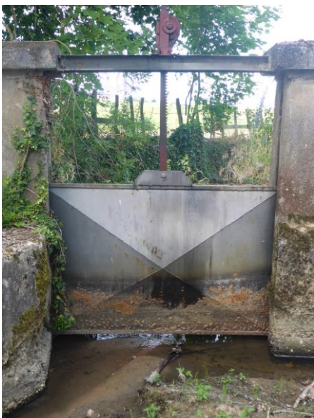
Vanne du bief de la Terrière
