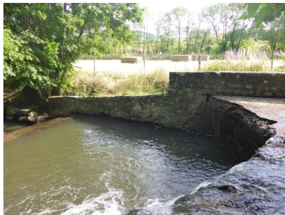
Bajoyer rive droite aval
