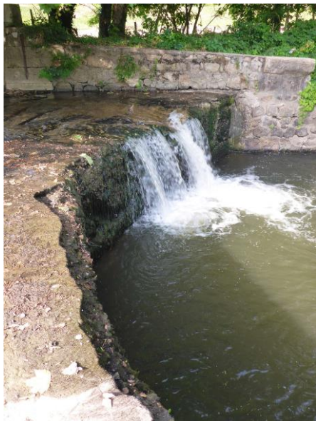
Crête du seuil amont
