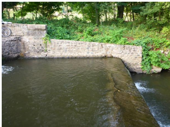
Bajoyer rive gauche
