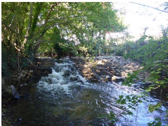
Seuil en aval du pont de Montmay (ROE60140)
