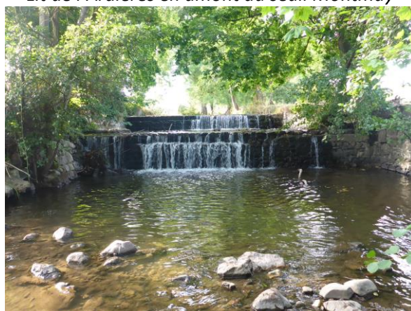
Seuil de prise d'eau du lavoir (ROE60138)
