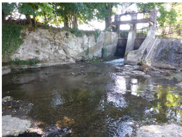
Bajoyer rive droite et vannes de vidange
