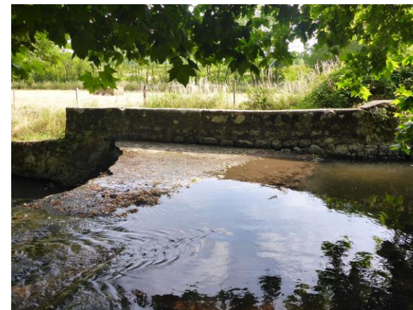
Crête du seuil amont et bajoyer rive droite amont
