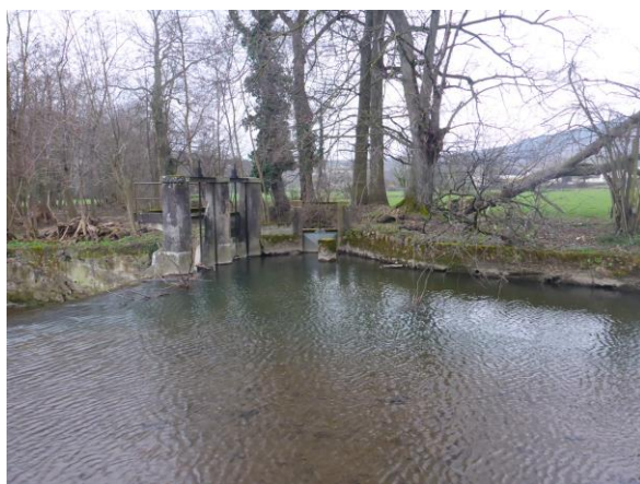
Seuil du bief des Moulins
