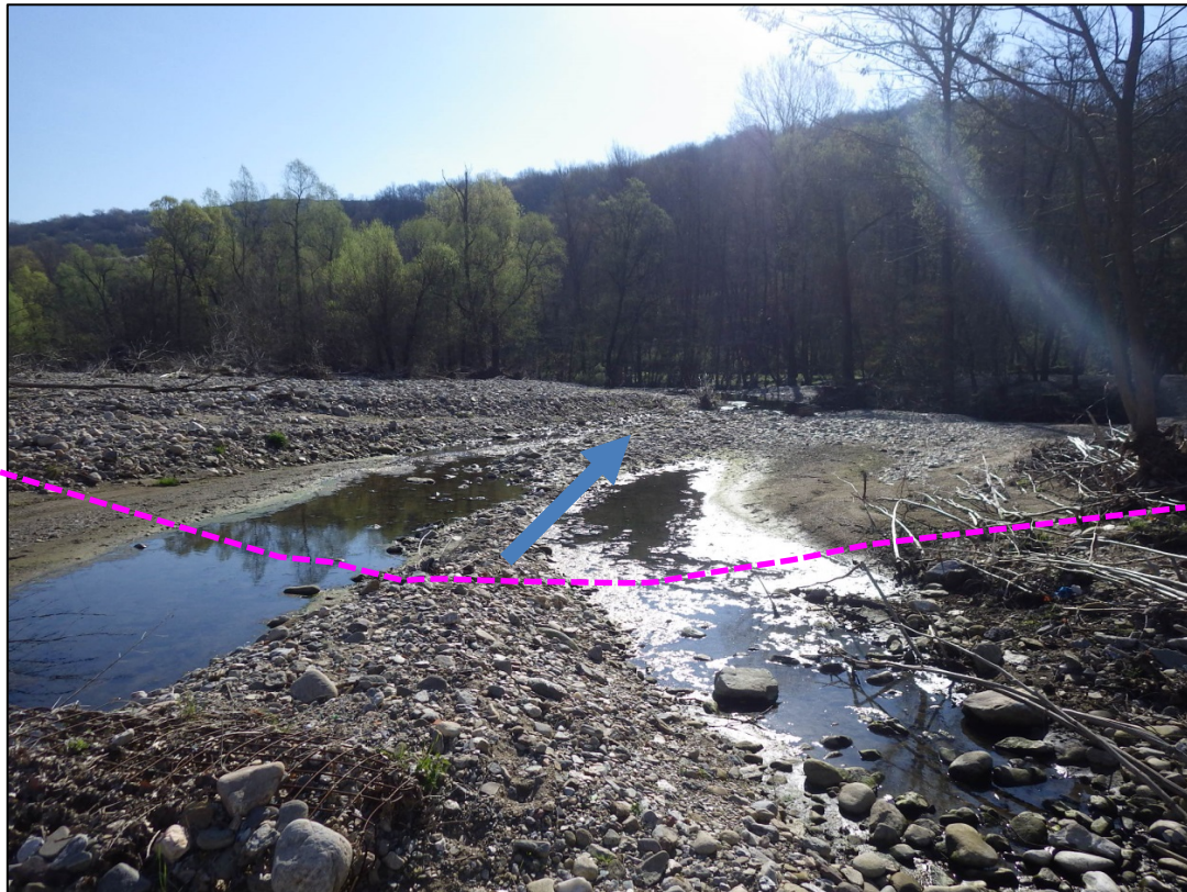
Figure 15 – Vue des travaux projetés en matière d'arasement d'un atterrissement de galets en partie médiane du tronçon n°9
