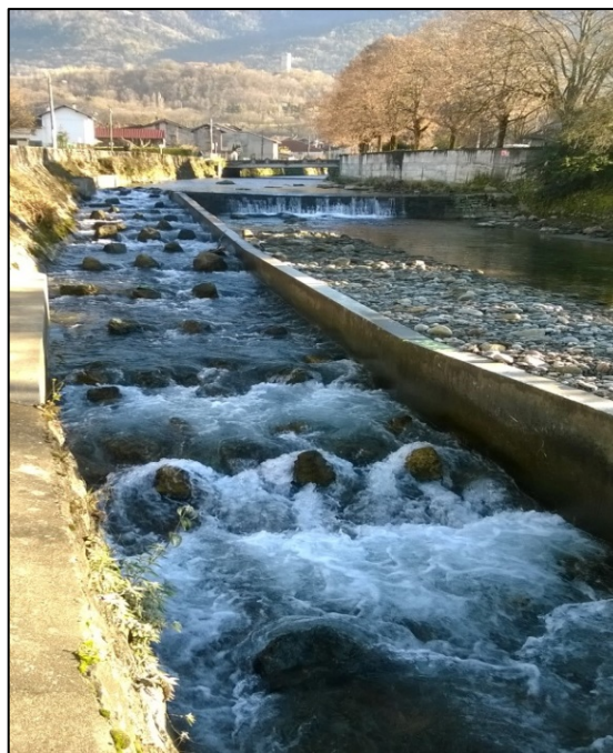
Illustrations d'une rampe en enrochements régulièrement répartis.
