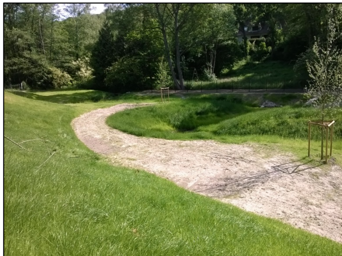
Figure 11 – Exemple de cheminements piétons en stabilisé et aménagements paysagers réalisés dans le cadre d'une opération de reméandrage de tronçon de cours d'eau. Source : EGIS.
