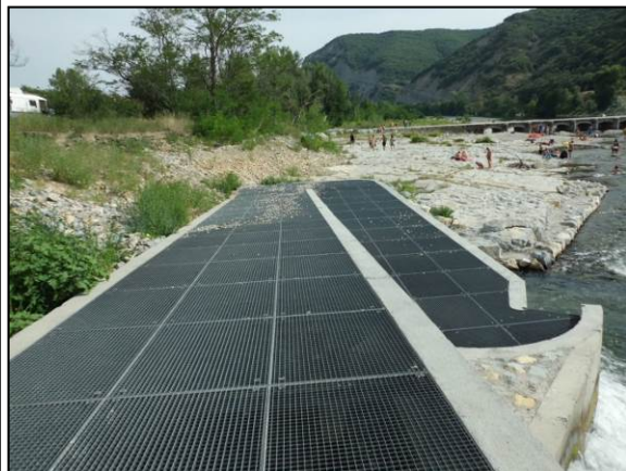
Exemple de passes à poissons de type bassins successifs.
