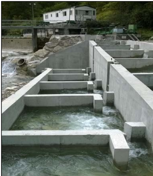
Exemple de passes à poissons de type bassins successifs.
