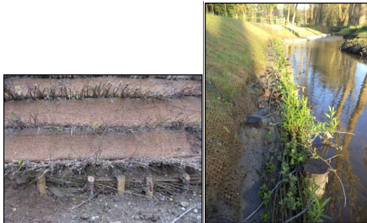
Figure 13 – Vues d'ouvrages de protection de pied de berge au moyen d'une fascine de saules à double rangée de pieux.
