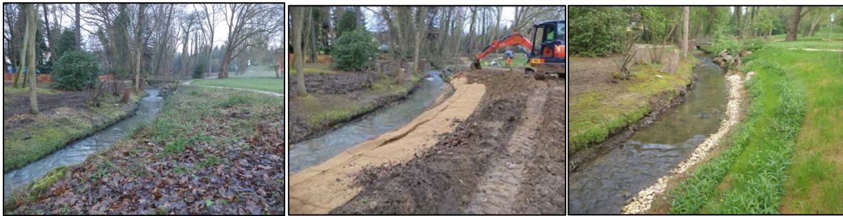
Figure 7 –Vue de travaux de décorrection d'un tronçon de berge au moyen de techniques 100 % végétales (fascine de saules + lits de plants & plançons). Source EGIS.
