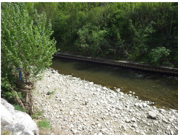
Banquette béton de soutien de la voie ferrée
