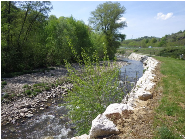
Ancien méandre protégé par des enrochements
