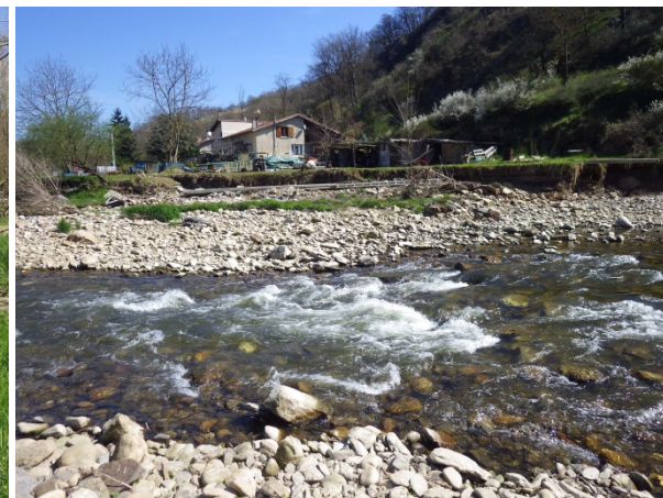
Erosion et atterrissement en aval du tronçon
