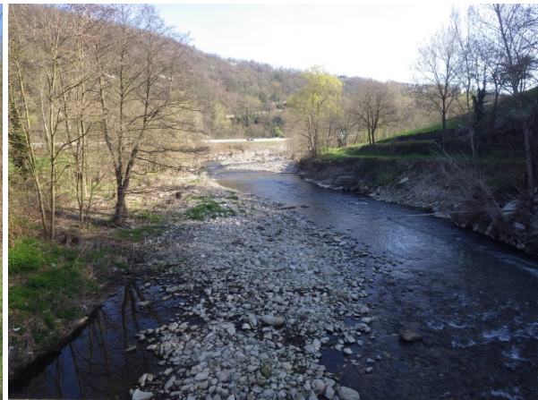
Aval du pont de La Fléchette
