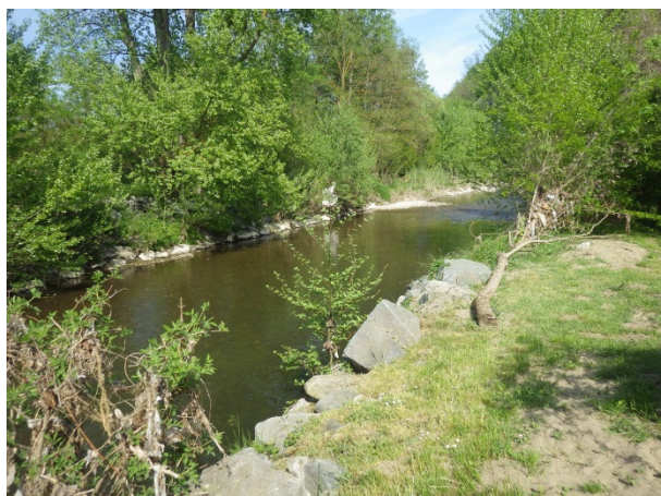
Protections en enrochements sur les deux rives
