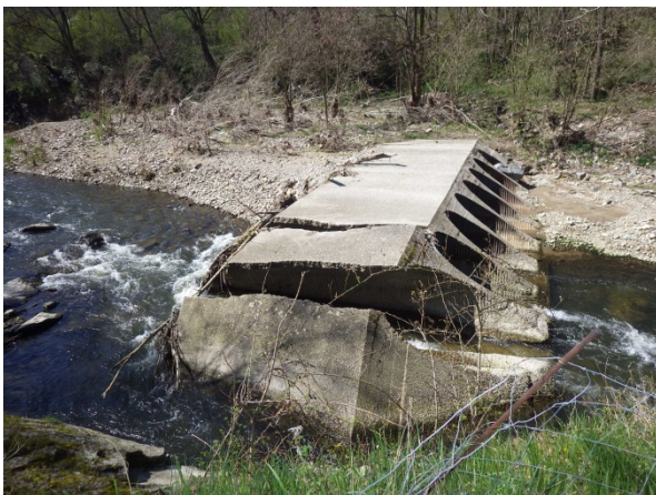
Ancien pont multi-buses
