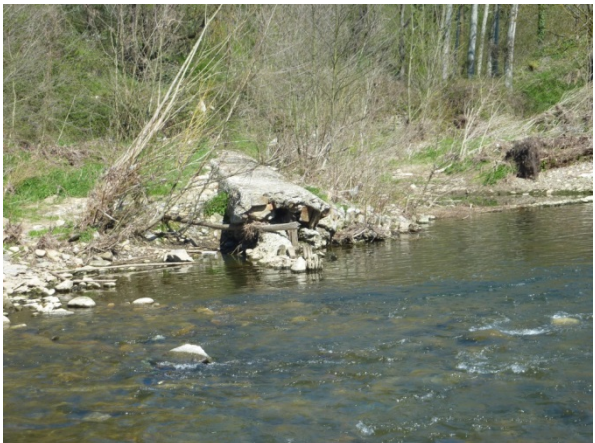
Ruines de l'ancien seuil de prise d'eau
