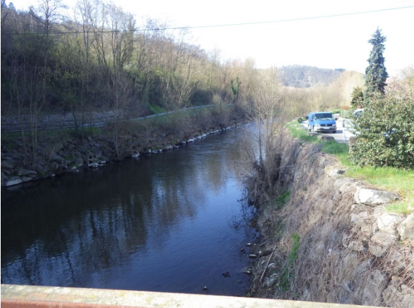
Enrochements en rives au droit de La Fléchette
