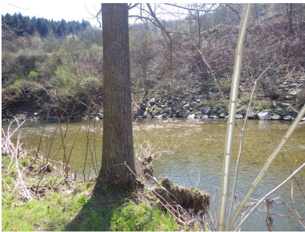
Enrochements en rive droite amont
