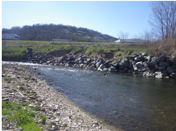
Enrochements déstabilisés en rive gauche
