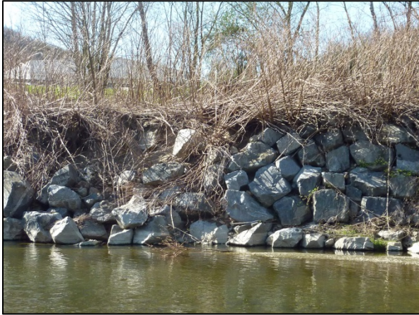
Au droit du lieu-dit La Fléchette (tronçon n°8)
