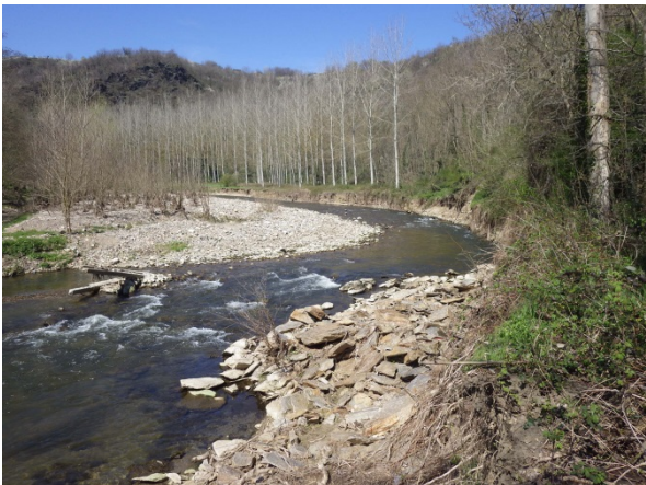
Erosion et atterrissement en aval du tronçon
