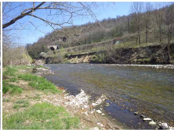
Zone de glissement de terrain talus voie ferrée
