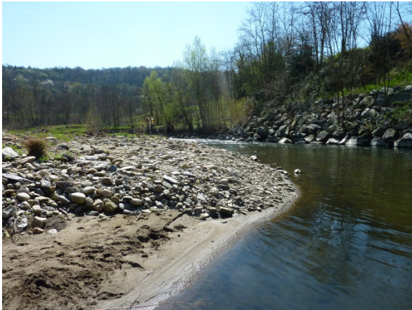
Enrochements en rive gauche amont
