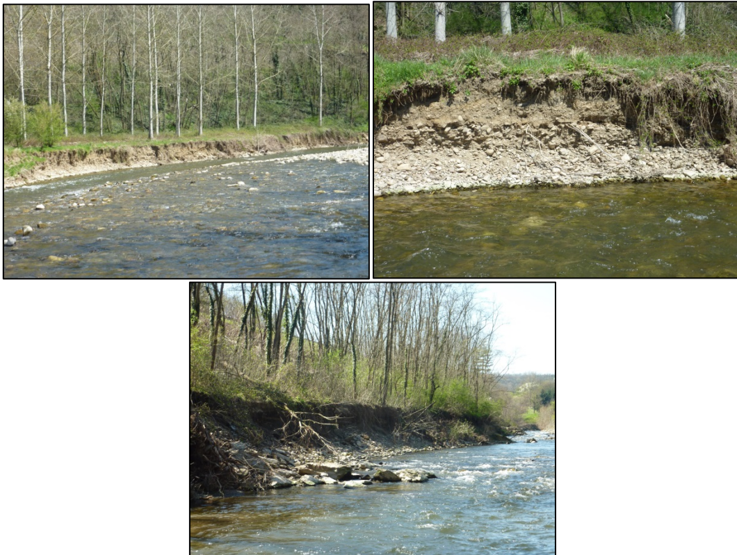
Vues de processus d'érosion de la berge gauche en aval du lieu-dit « Rocher Percé » (photos en haut) et de la berge droite en amont de ce même lieu, en pied du remblai autoroutier (photo en bas)
