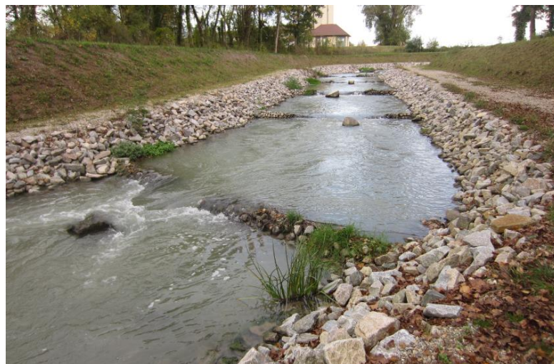
Avant-projet de la rivière de contournement du seuil et exemple de passe à poisson similaire (Jons, sur le Rhône)
