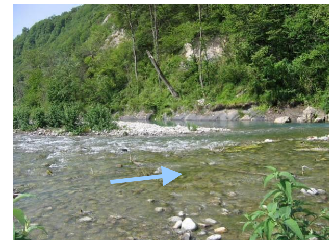
Radier infranchissable à 1,5 m 3 /s sur T1a (photographie prise à 3 m 3 /s)
