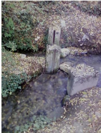
Anciennes vannes guillottes sur le canal de Malissoles
