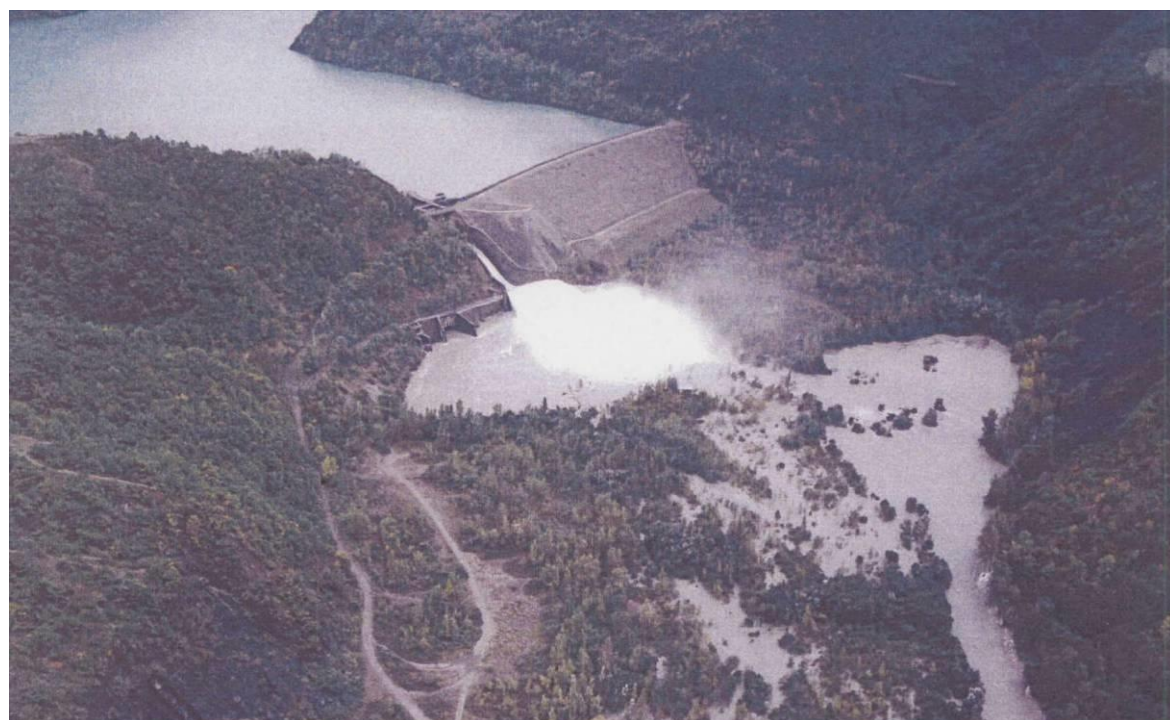
Déversés au barrage de ND de Commiers lors de la crue d'Octobre 1993 (Source EDF)
