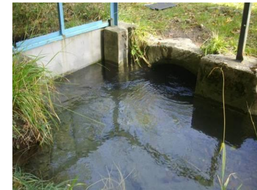
FIGURE 15 : CANAL DE MALISSOLES – VANNAGE ET DIFFLUENCE PERMETTANT L'ALIMENTATION DE LA CHASSE BARBIER
