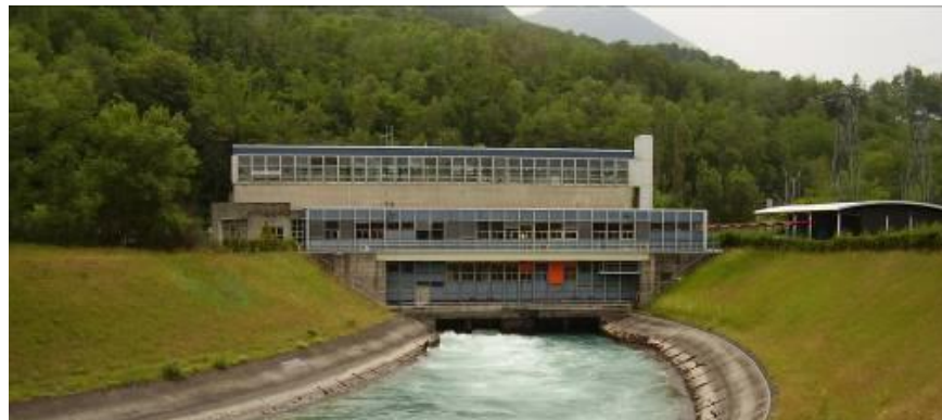
Centrale hydroélectrique de Saint Georges de Commiers
