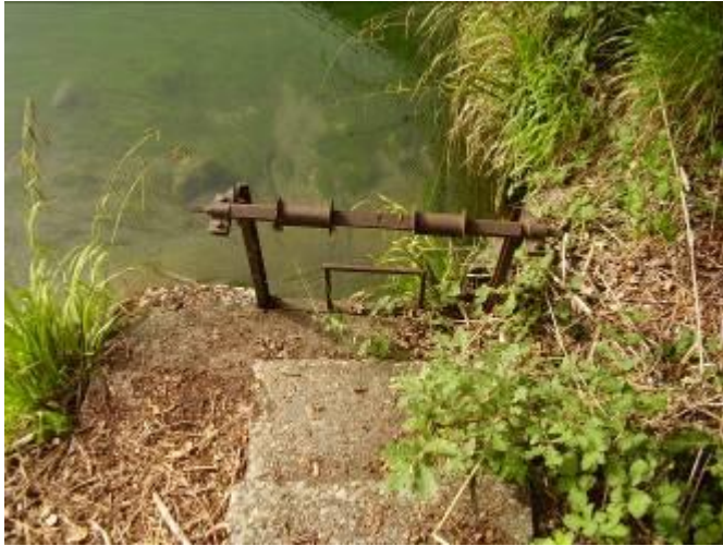
Prise d'eau en rive gauche du seuil de la Rivoire (2010)
