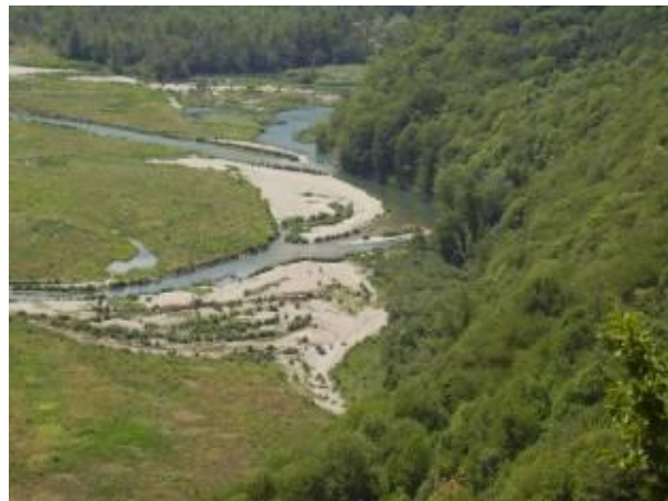
Erosion en extrados et recoupement de méandres (tronçon 2)
