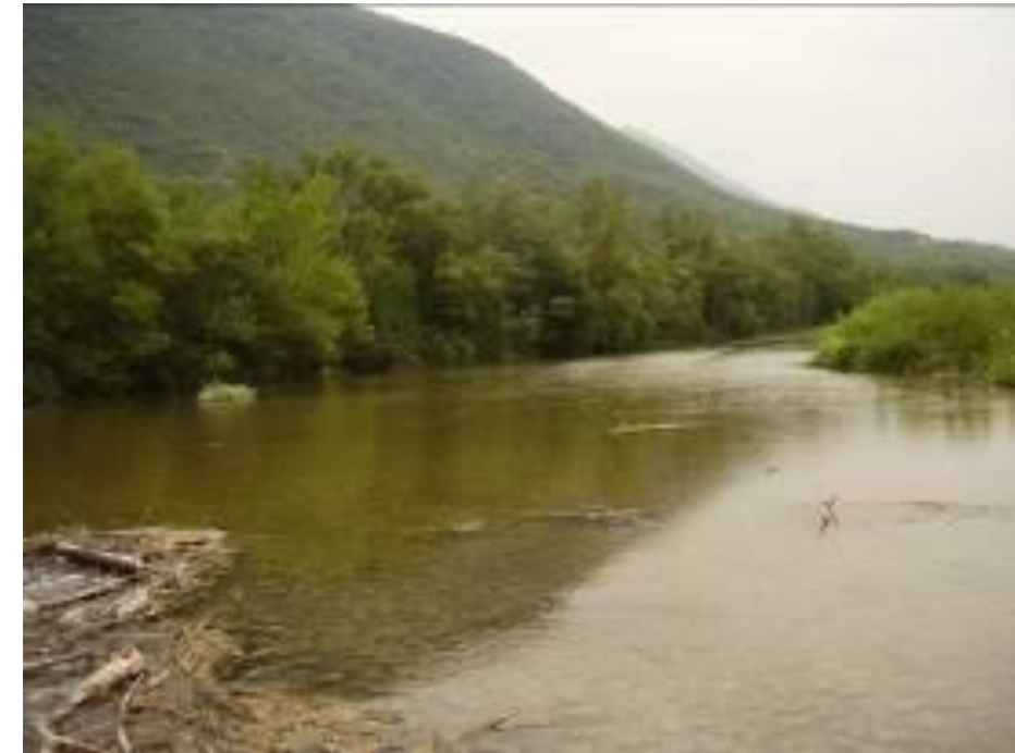
Long plat le long de la digue rive droite (vue de l'aval)
