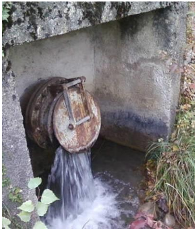
Trop plein du Canal de Malissoles
