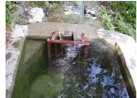
FIGURE 14 : CANAL DE MALISSOLES – SECTION COURANTE ET OUVRAGE DE TROP PLEIN AU PIED DU PETIT BRION
