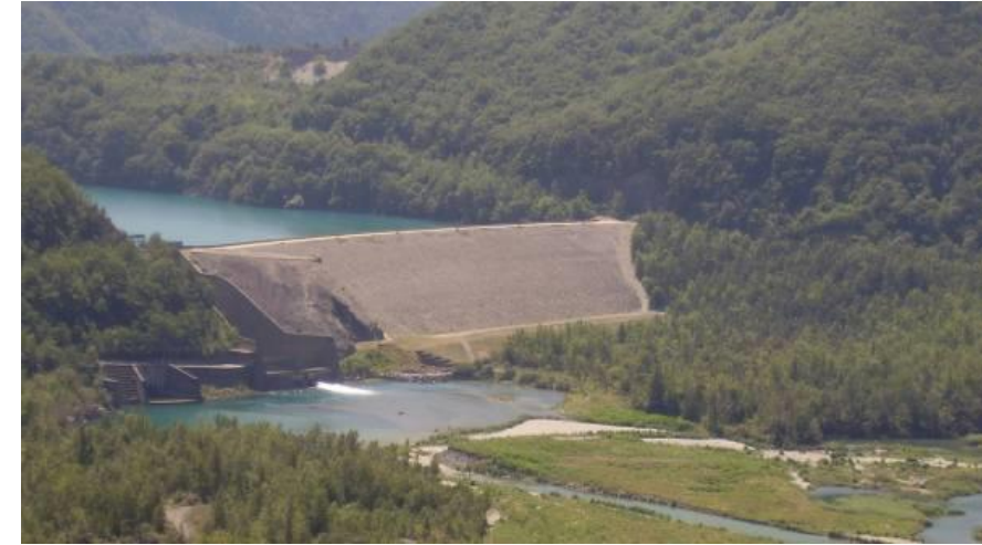
Vue du barrage de Notre Dame de Commiers depuis le hameau de Chabotte
