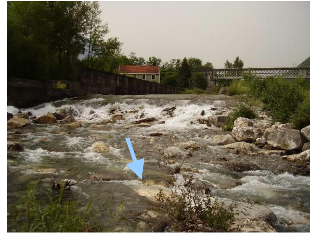
Coursier aval du seuil de la Rivoire, infranchissable
