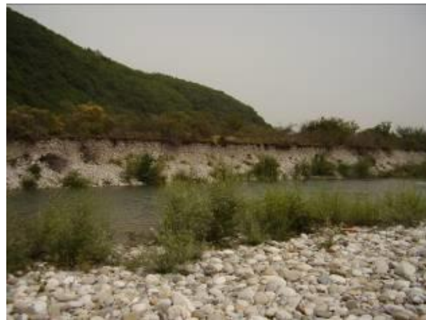
Erosion d'une terrasse dans l'extrados d'une courbe (tronçon 5)
