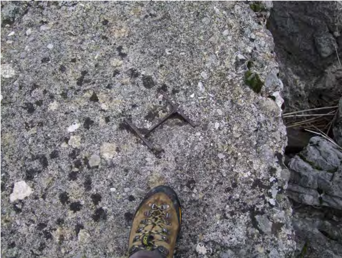
Renforcement par profilé métallique en H
