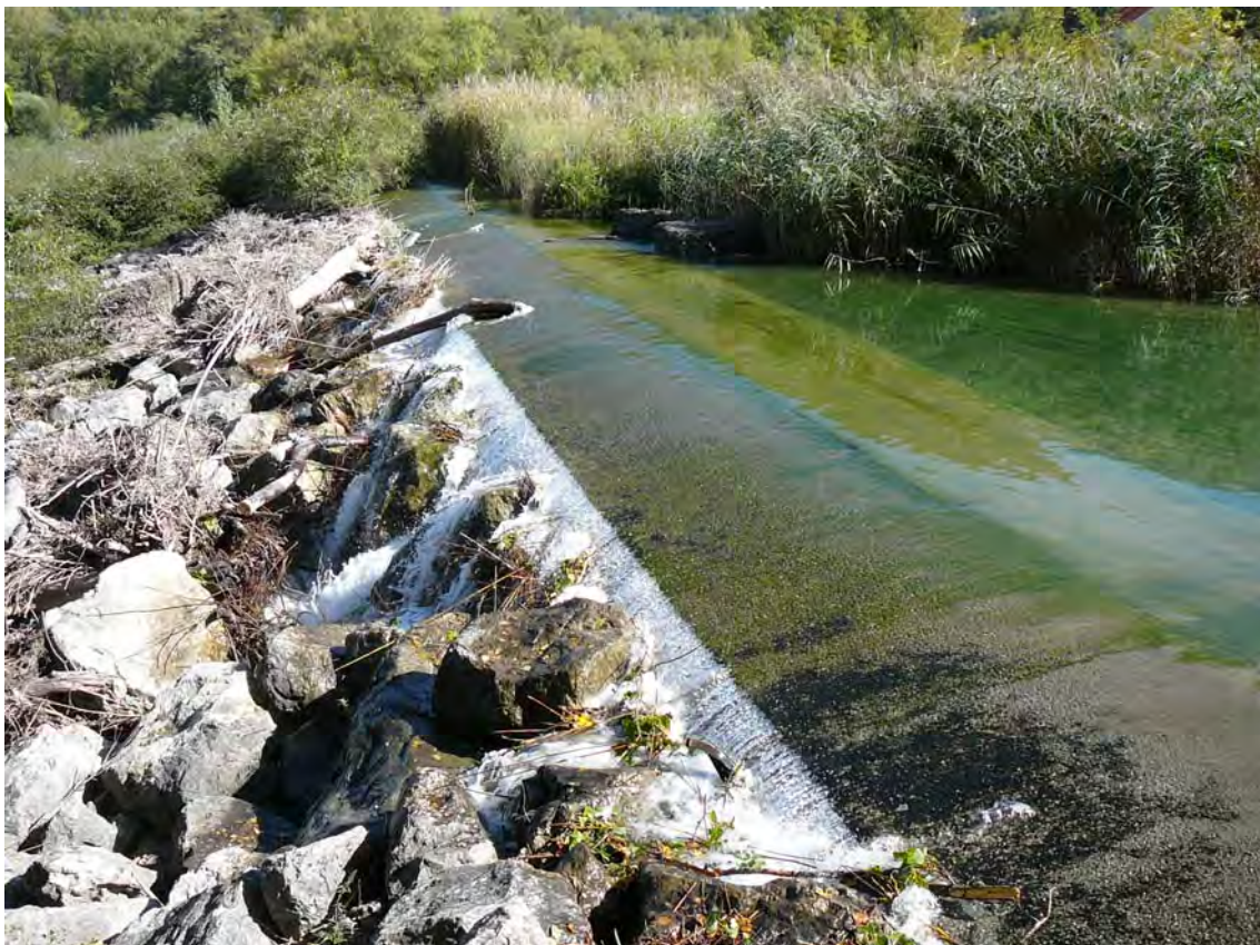
Crête côté rive gauche et enrochements aval
