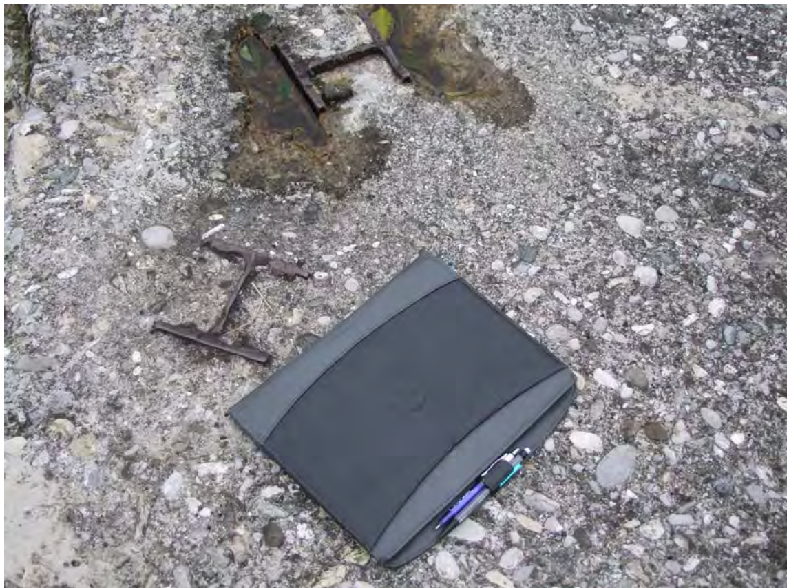
Renforcement par profilés métalliques en H
