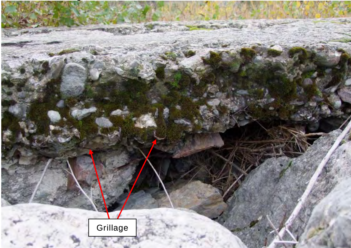
Crête béton depuis l'aval
