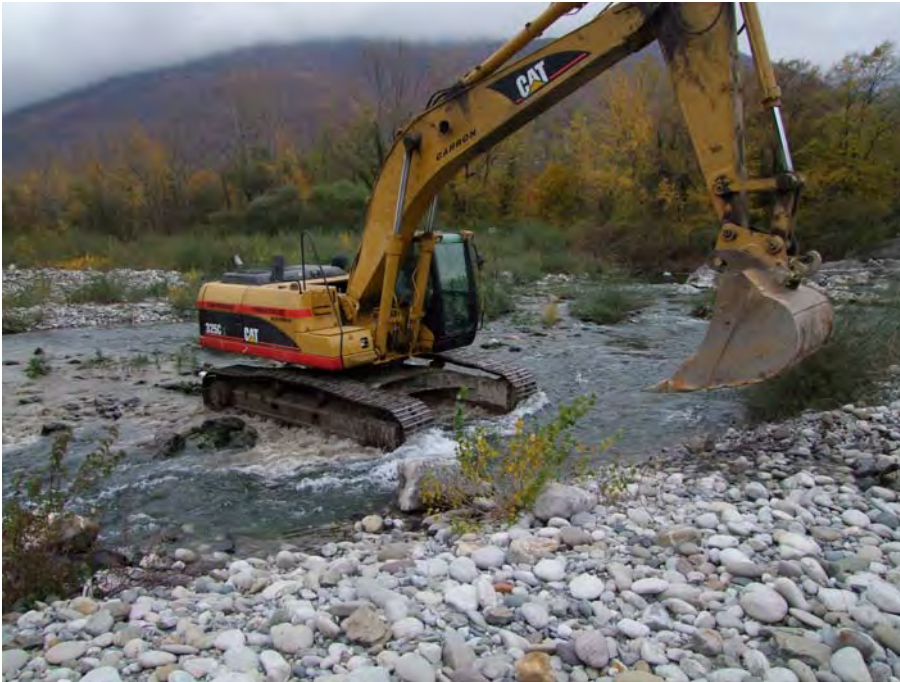
Vue de la pelle mécanique utilisée pour les sondages
