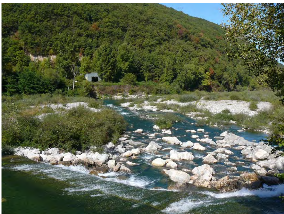
Enrochements en aval du canal de dérivation
