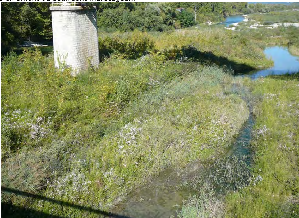
Terrains en amont du seuil
