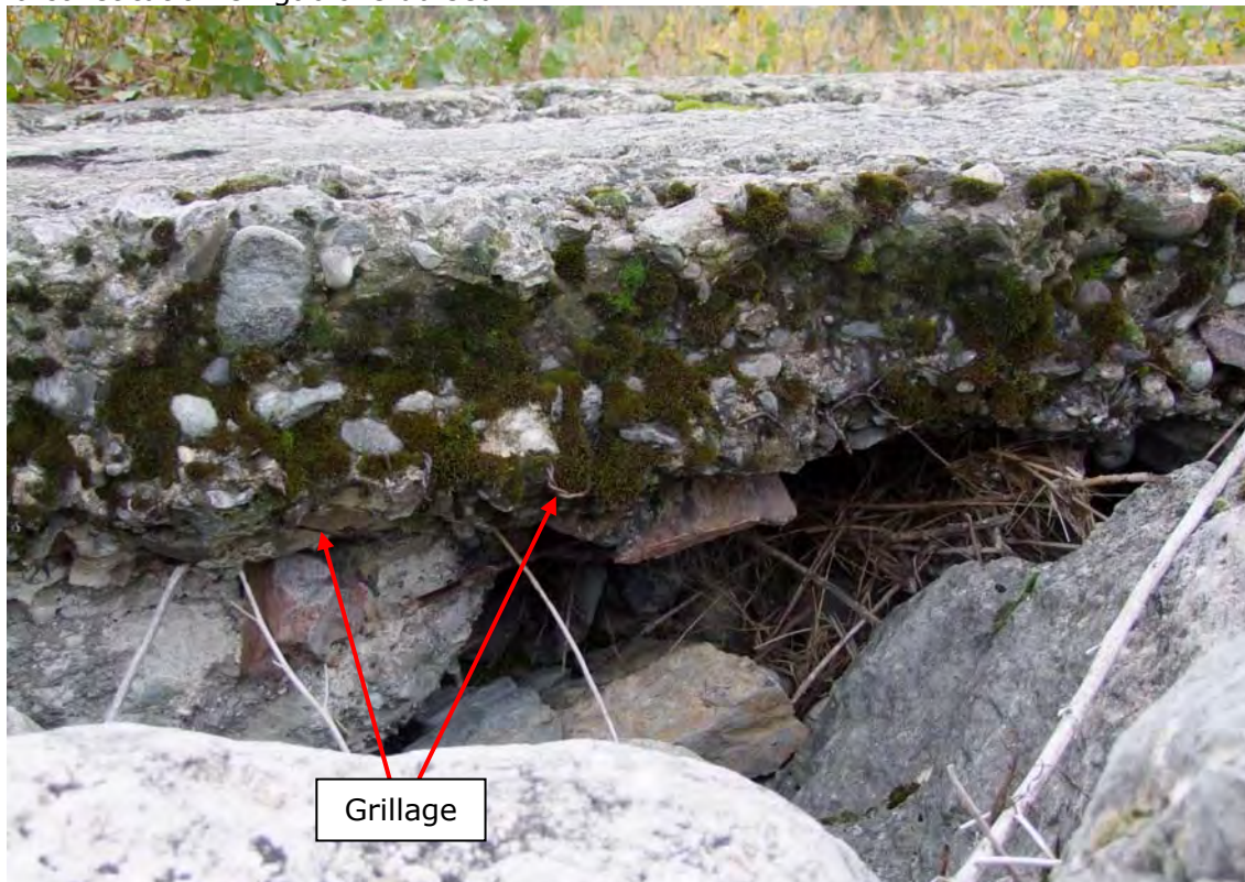
Crête béton depuis l'aval
