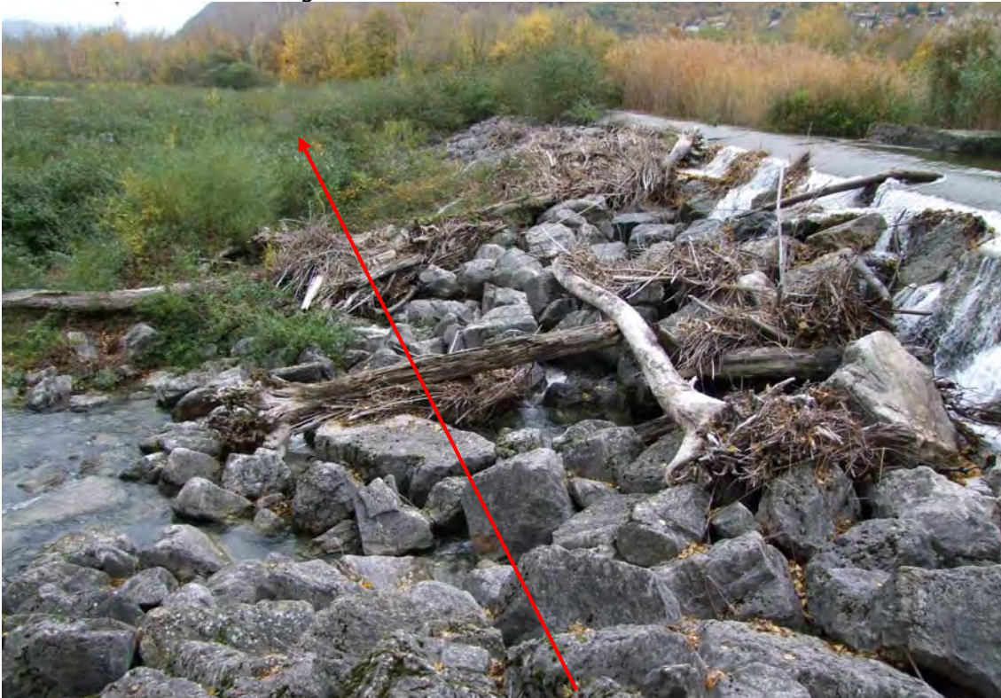
Parement aval végétalisé
