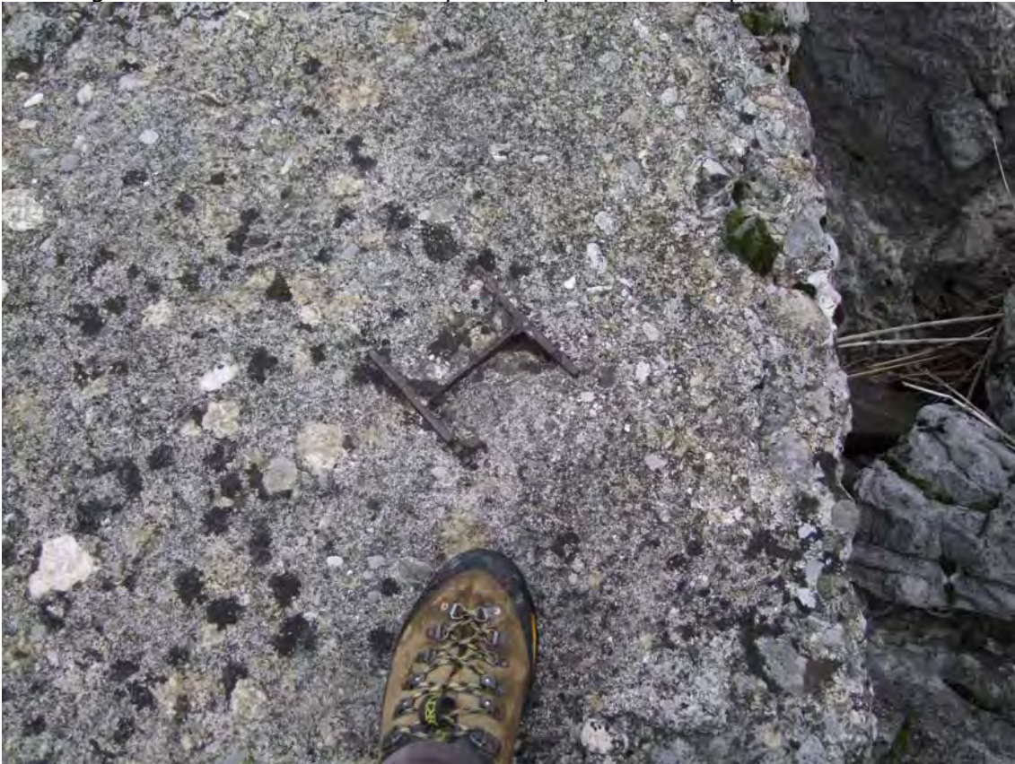
Renforcement par profilé métallique en H
