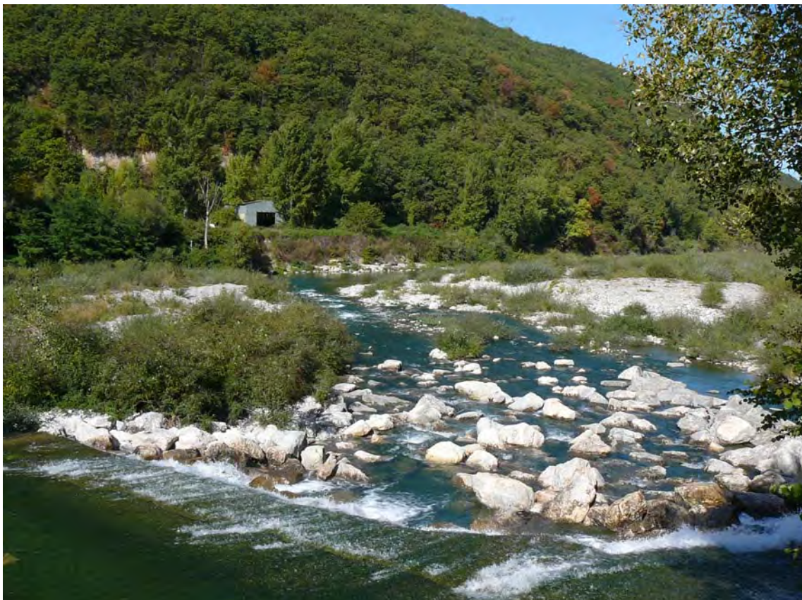
Enrochements en aval du canal de dérivation
