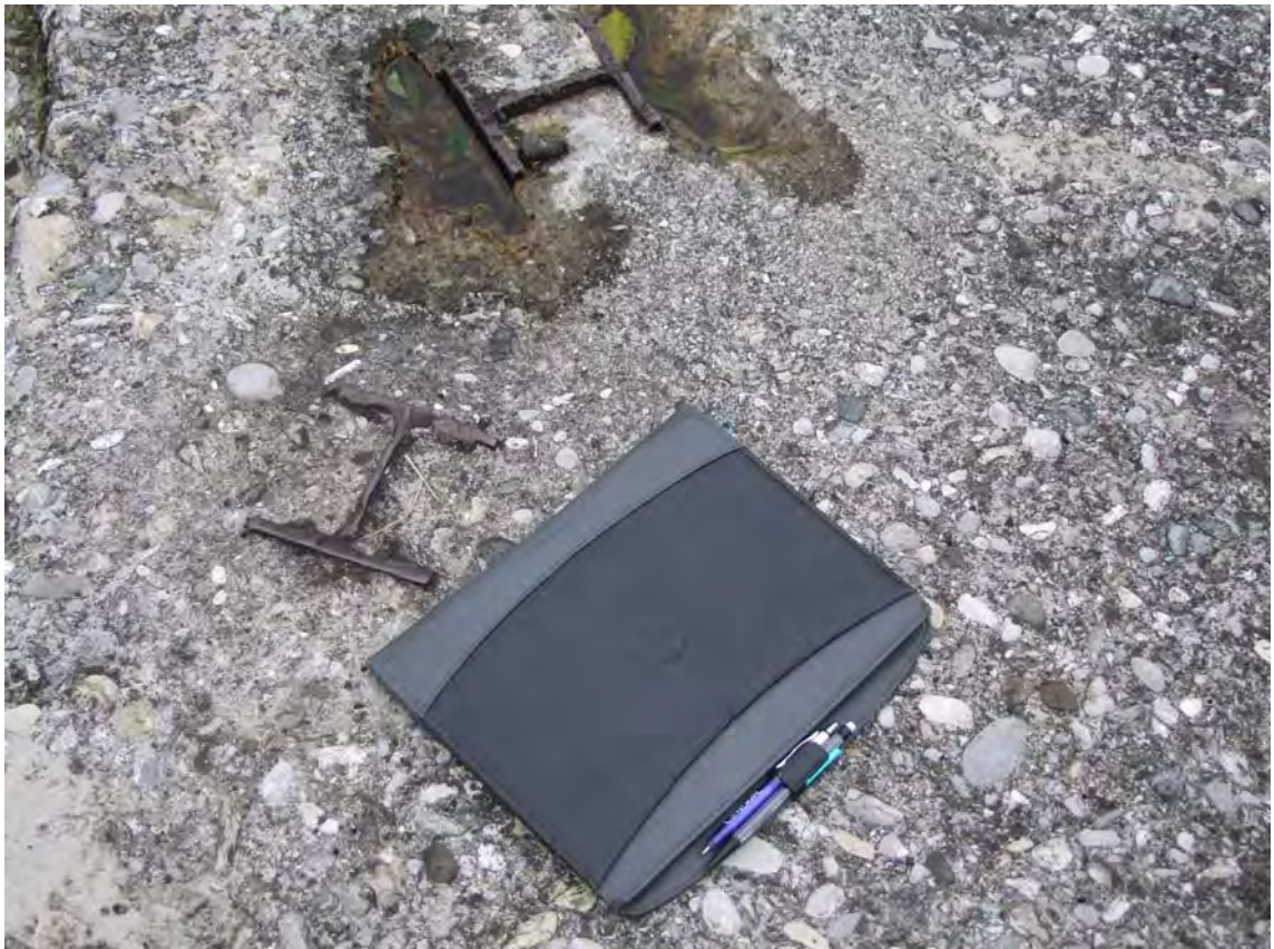
Renforcement par profilés métalliques en H
