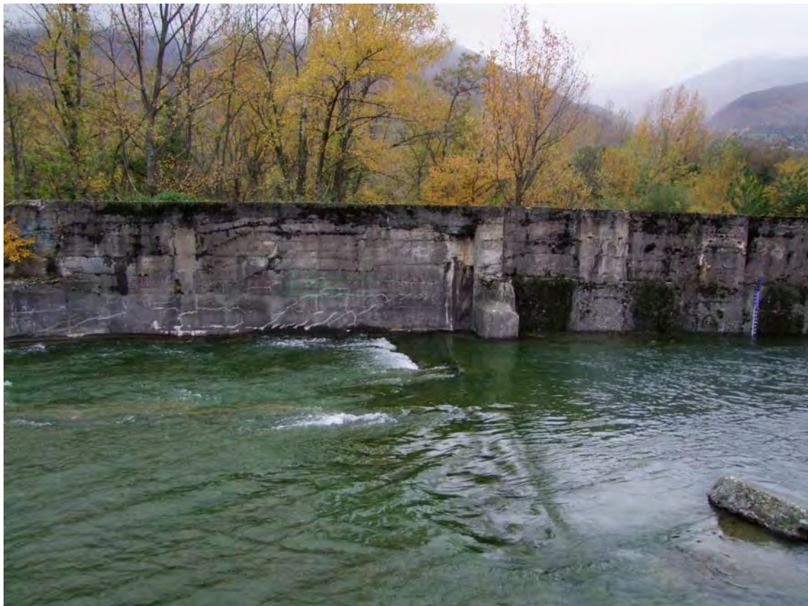
Vues générale et de détail du mur de soutènement en rive droite
