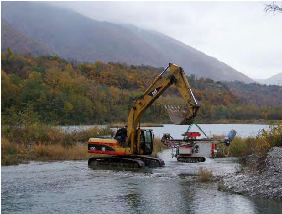
Vue de la machine utilisée pour les sondages (transport par pelle mécanique)
