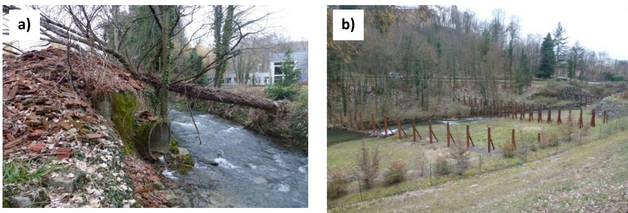
Figure 3. Problématique des embâcles : a) bois tombé en travers du lit de la Morge ; b) piège à corps flottants sur la Morge à l'entrée de Voiron
