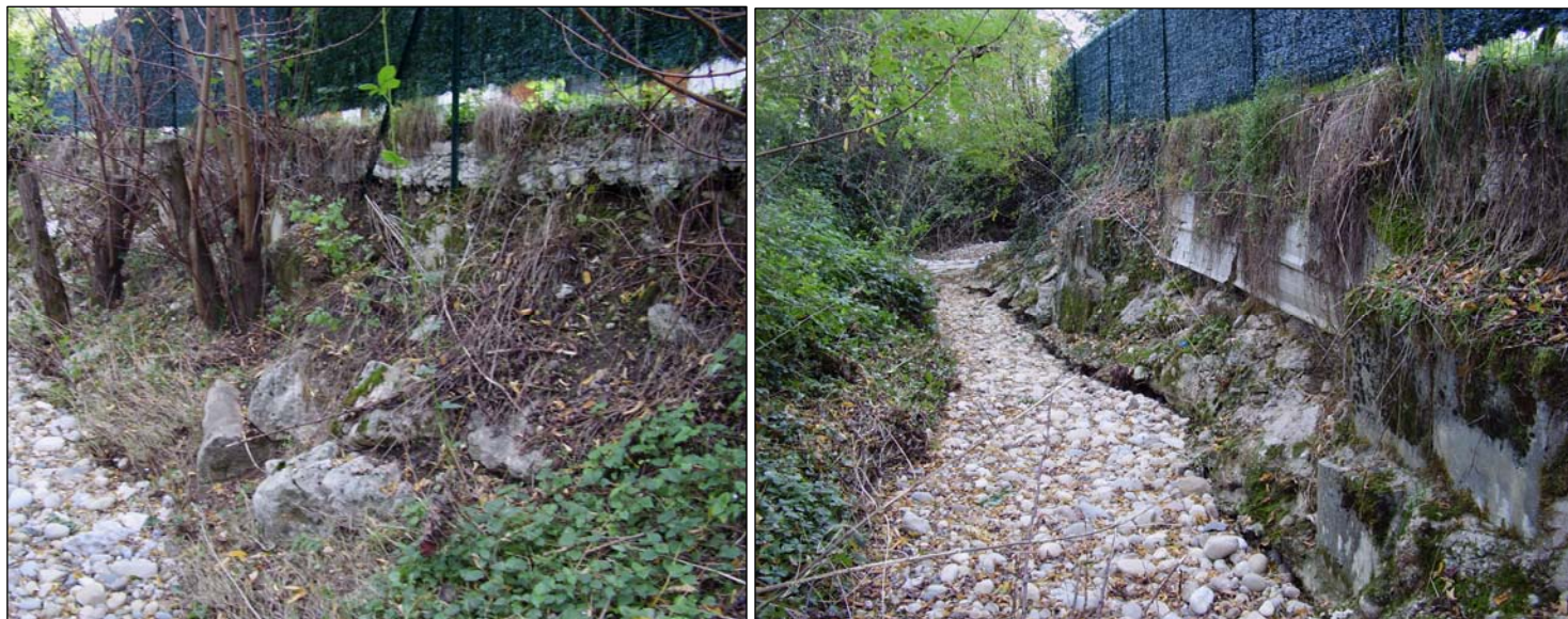
AVOUX – rive droite – MONTLUEL – Tresset protections berge et talus digue ± élaborées N.B. Début déchaussement pied de protection
