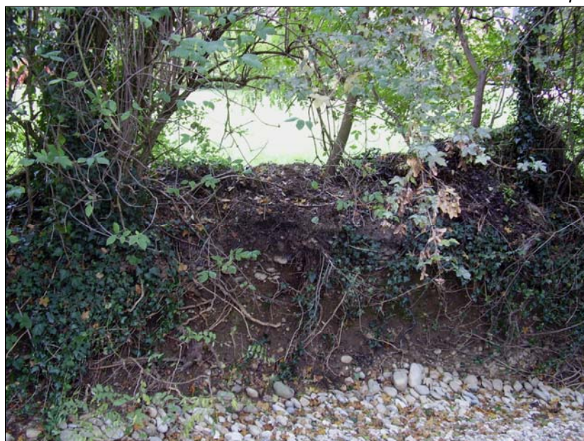
AVOUX – rive droite – MONTLUEL – Tresset protections berge et talus digue ± élaborées N.B. Début déchaussement pied de protection
