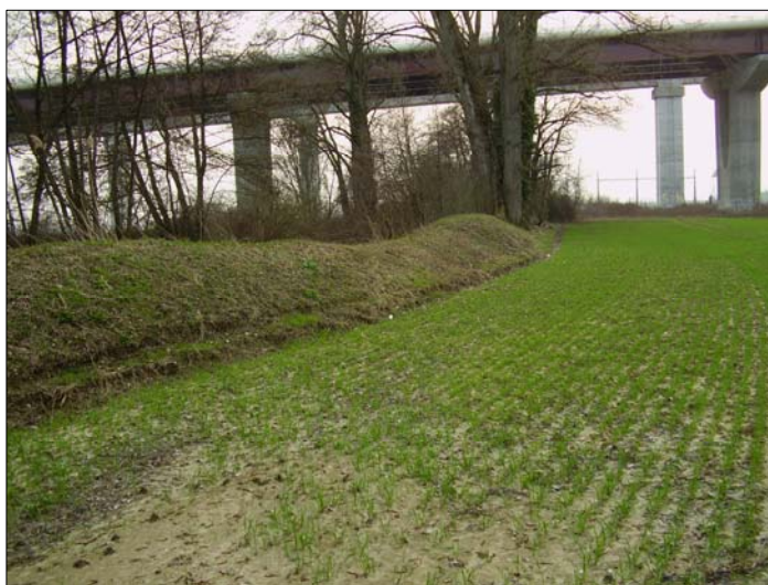
SEREINE – rive droite – Tronçon S06d ci-dessus digue avec variation importante du niveau de crête ci-dessous à gauche : secteur avec désordres anciens (terriers)
