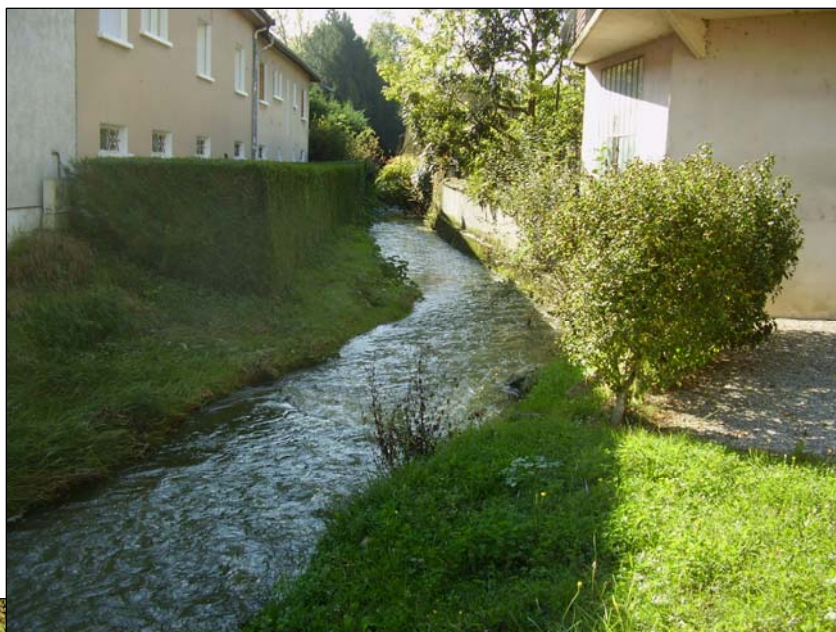
COTÉY – début de tronçon C06 cours d'eau canalisé
