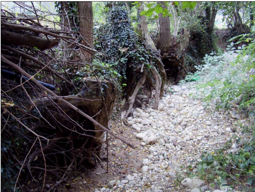
AVOUX – amont du pont de la RD61 érosion en rive gauche côté lotissement DAGNEUX
