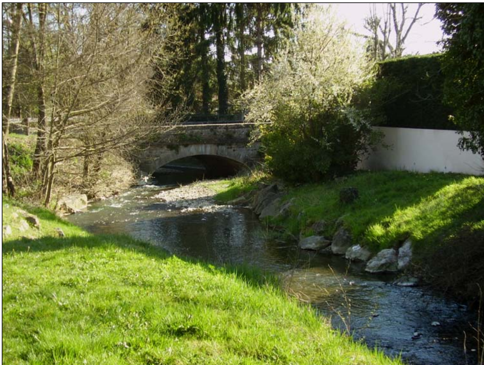
COTÉY – fin de tronçon C08 pont rue du Cottey
