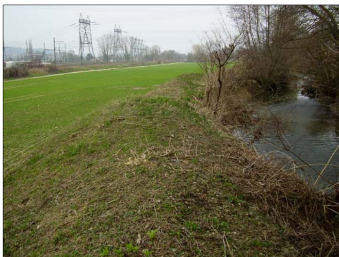
SEREINE – rive droite – Tronçon S06d ci-dessus digue avec variation importante du niveau de crête ci-dessous à gauche : secteur avec désordres anciens (terriers)
