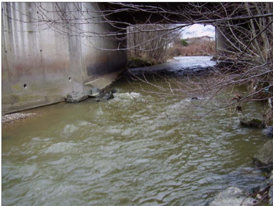
SEREINE – début du tronçon S10 Pont sous la RD61a
