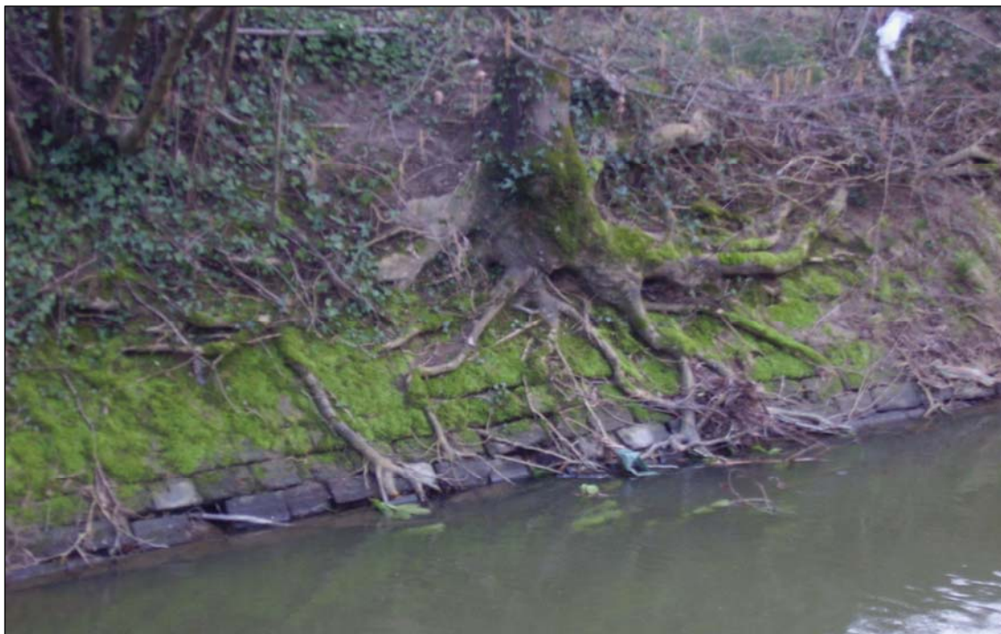
SEREINE – rive gauche – Tronçon S06g – premier coude après voie ferrée
