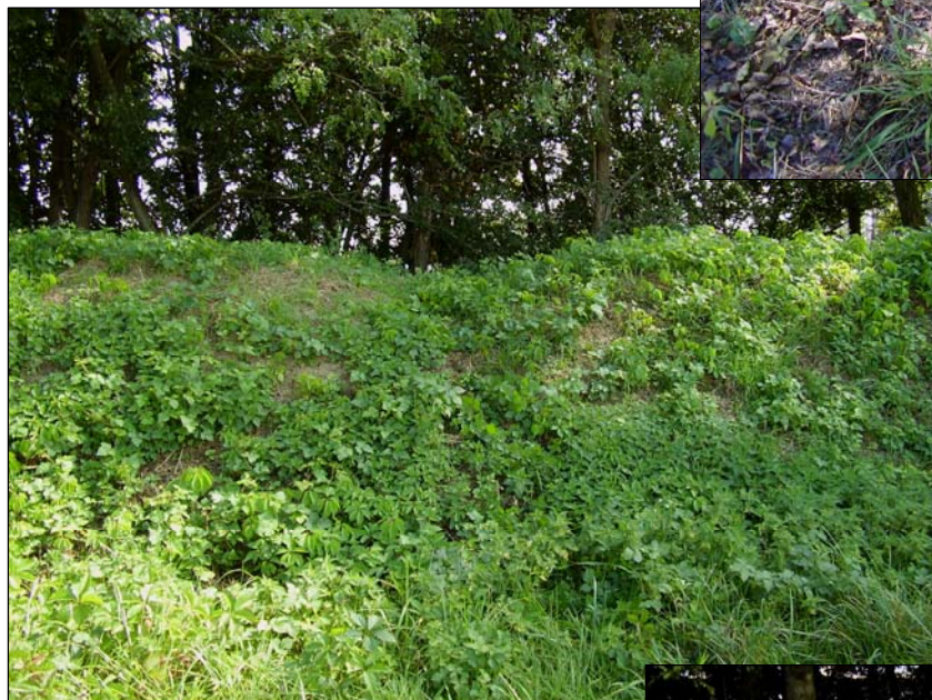
SEREINE – rive droite – Tronçon S05d désordres dans la digue : point bas ci-contre plus ou moins cicatrisé ancien point de débordement ?
