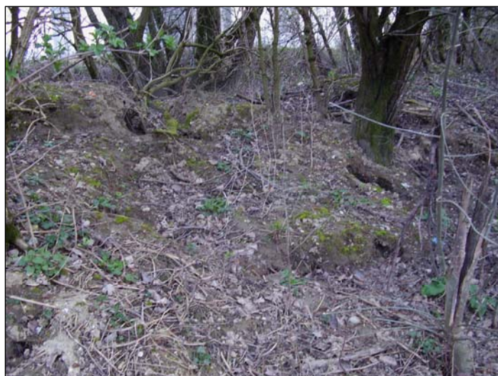
SEREINE – rive droite – Tronçon S06d ci-dessus digue avec variation importante du niveau de crête ci-dessous à gauche : secteur avec désordres anciens (terriers)
