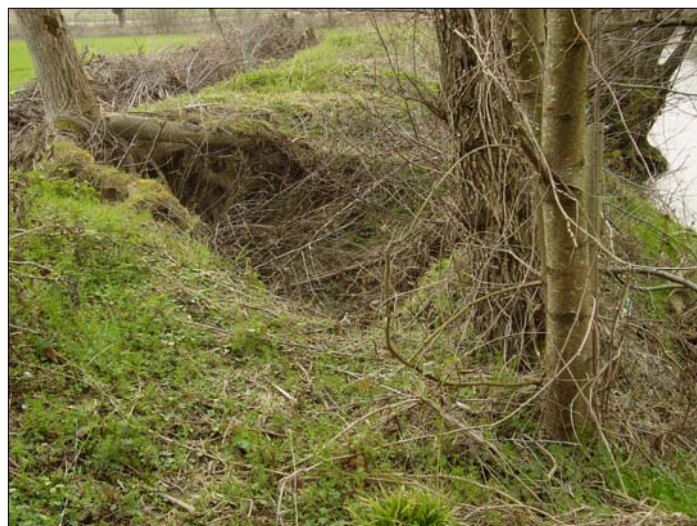
SEREINE – rive gauche – Tronçon S06g désordre important type renard d'érosion interne
