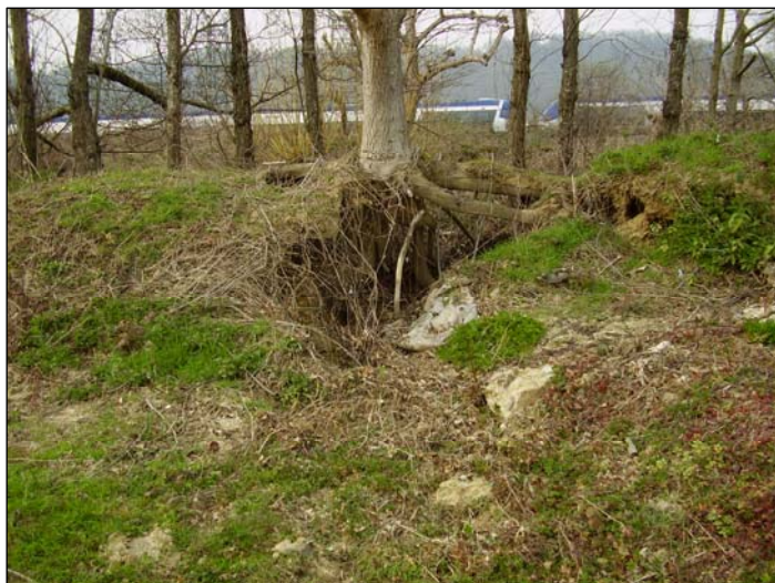
SEREINE – rive gauche – Tronçon S06g désordre important type renard d'érosion interne
