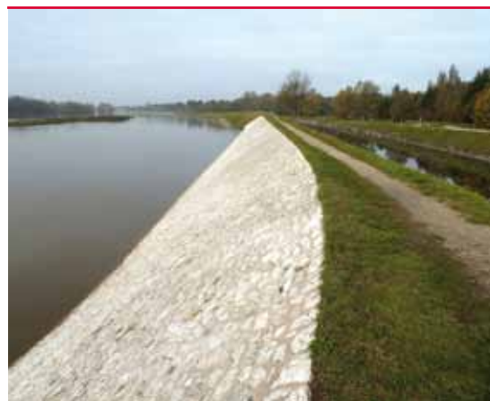
Digue sur la Loire en crue
