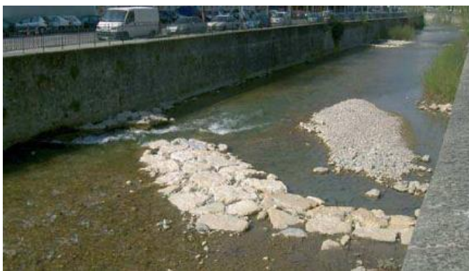
Illustration 1 - Travaux sur la Leysse dans la traversée de Chambéry : mise en place d'ouvrages de diversification des écoulements et végétalisation
