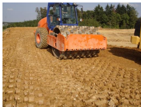
Photographie 13 - Compactage par rouleau "pied de mouton"
