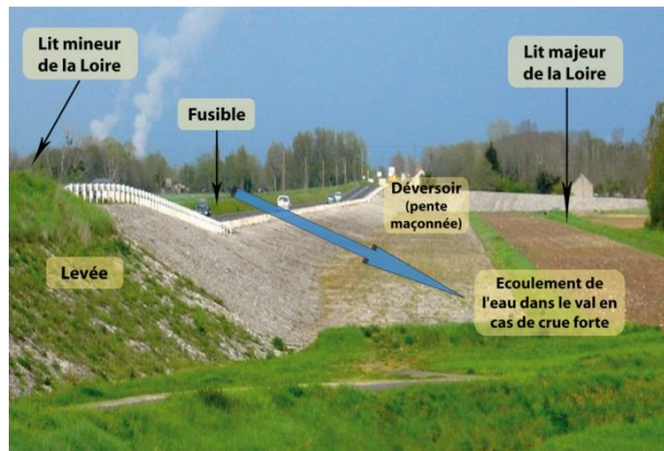
Figure 20 - Déversoir de la Loire à Montlivault
