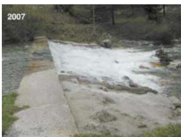
Photographie 10 - Photographie 9 - Illustration d'un abaissement d'ouvrage
