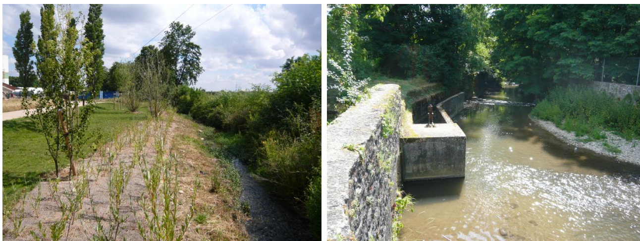
Photographie 12 - Le canal du Moulin Cassal dans le parc d'activités (à gauche) et sa prise d'eau dans la Sereine (à droite)
