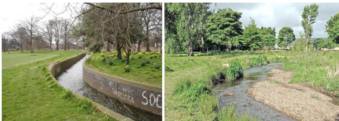
Photographie 7 - Retrait des murs et du fond bétonné (Royaume-Uni)
