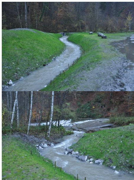
Photographie 8 - Illustrations de différents dérasements d'ouvrages
