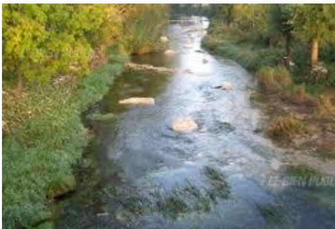
Photographie 4 - Blocs de diversification sur l'Ource
