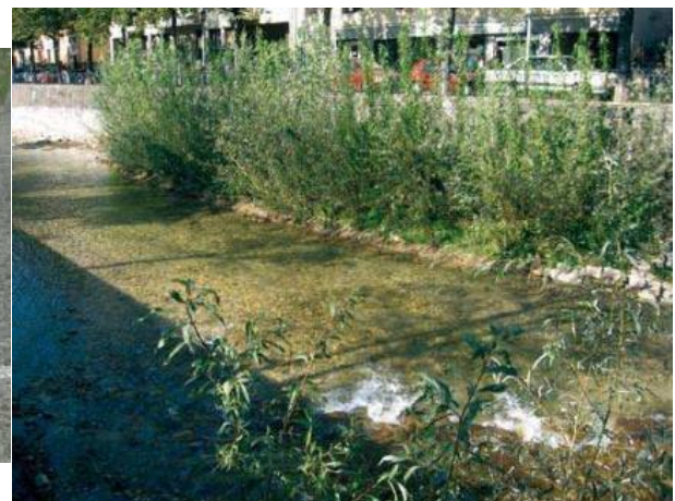
Illustration 1 - Travaux sur la Leysse dans la traversée de Chambéry : mise en place d'ouvrages de diversification des écoulements et végétalisation
