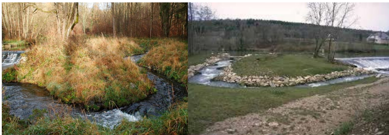
Photographie 9 - Illustrations de différents types de rivières de contournement (l'ouvrage est conservé, la franchissabilité piscicole se fait dans le nouveau chenal)
