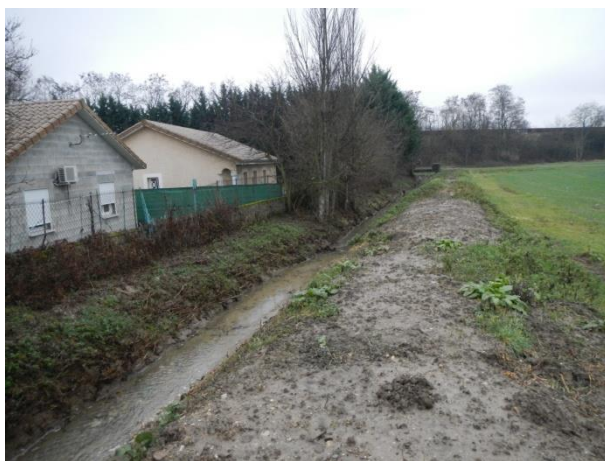
Photographie 11 - Le Merdanson entre la RD 1084 et la voie ferrée
