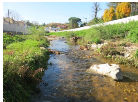
Photographie 4 : L'Yzeron à Oullins après travaux
