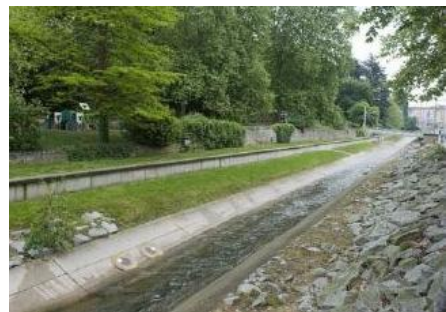
Photographie 3 : L'Yzeron à Oullins avant travaux (source : CNR)
