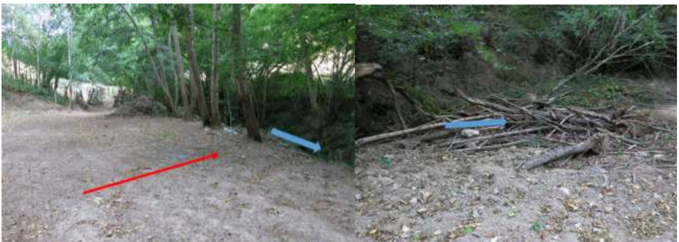
Figure 12 : Photos montrant l'impact des remblais sur le lit du ruisseau de Marchampt
