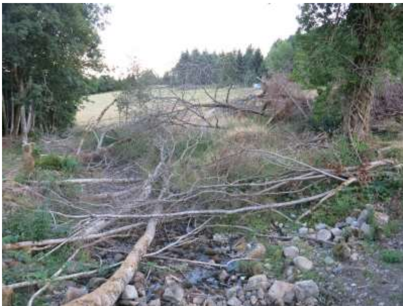
Figure 24 : Lit de l'Ardières amont obstrué par les troncs et branches
