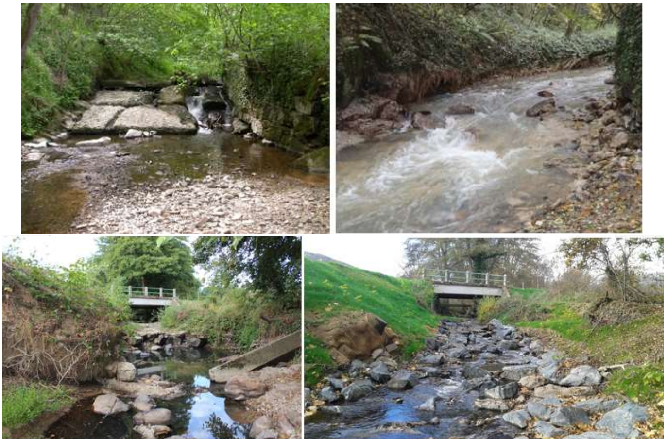
Figure 26 : Arasement (en haut) et aménagement (en bas) de deux ouvrages infranchissables sur le ruisseau des Samsons
