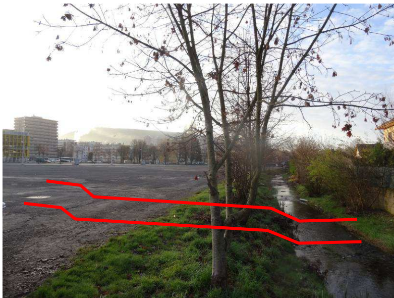
Risberme en rive gauche, abaissant les hauteurs d'eau et aménagements environnementaux
