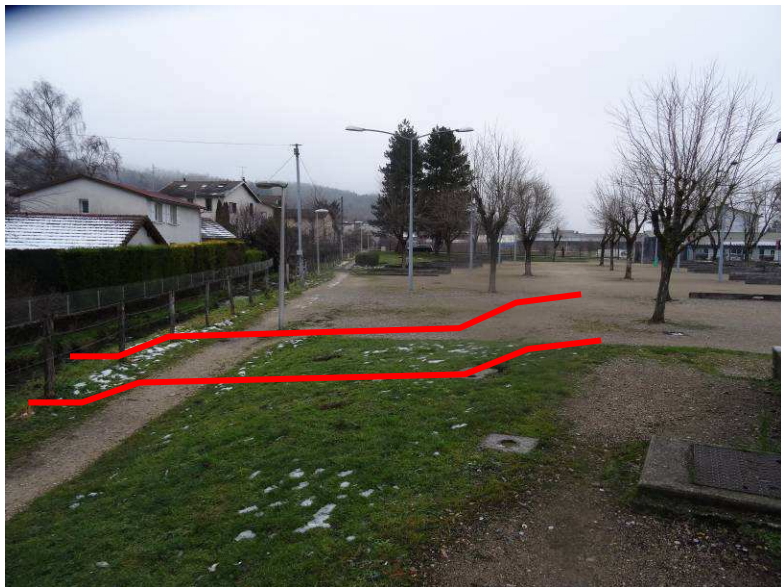
Risberme en rive gauche, abaissant les hauteurs d'eau et aménagements environnementaux
