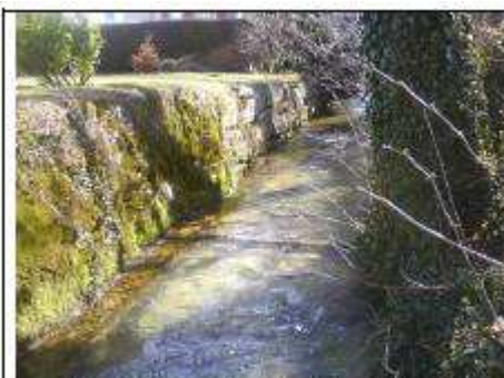
Rétrécissement au droit du poste EDF
