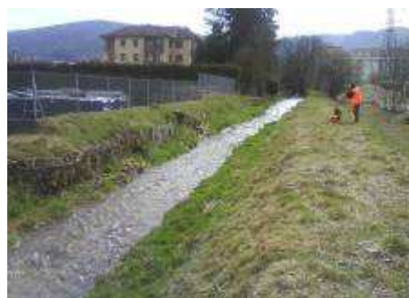
Digue actuelle en mauvais état, à modifier
