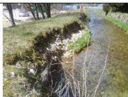
Anse d'érosion à l'aval immédiat du rétrécissement
