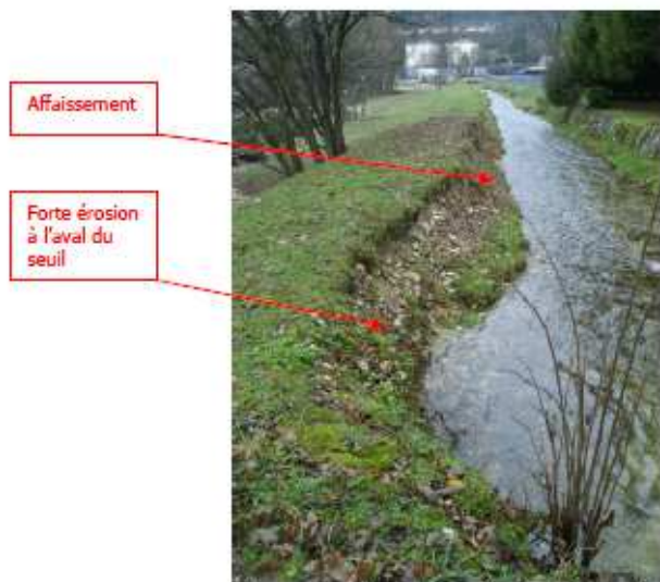
Digue actuelle en mauvais état, à modifier
