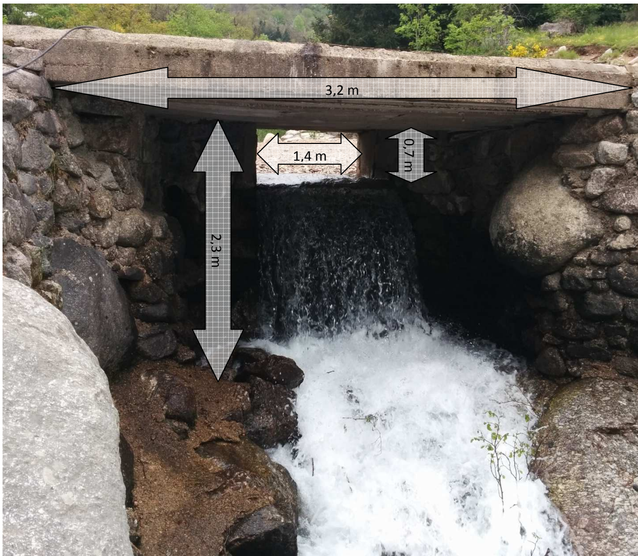
Figure 6 : seuil sur la Drobie au camping de Sablière
