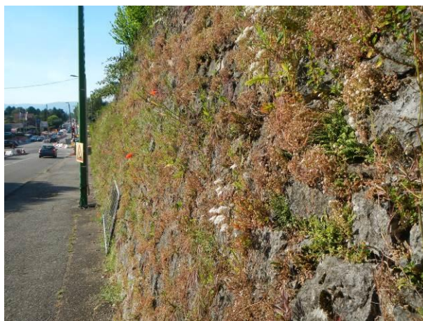
Figure 6 : Exemple d'un mur avec une végétation diversifiée se rapprochant de la végétation des parois calcaires ensoleillées
