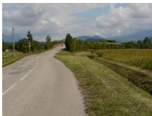
Photo 2 illustrant le passage du chemin de Lachal sur l'A 51 © V. Vignon OGE
