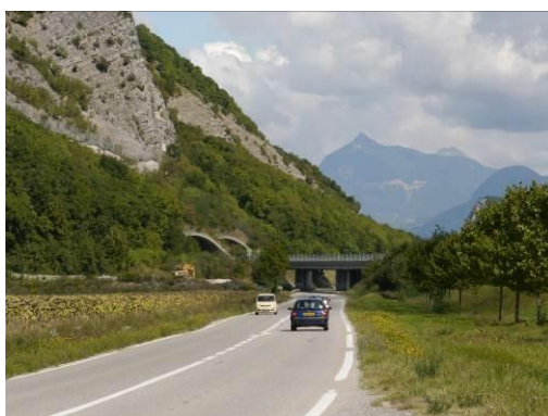
Photo 1 illustrant le passage de la D 1075 sous l'A 51 © V. Vignon OGE
