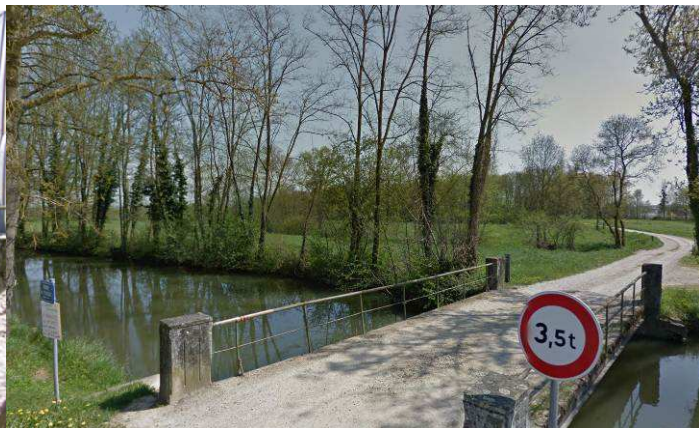
Vue en amont du vannage du moulin de Polaizé sur la Veyle (photographie google)
