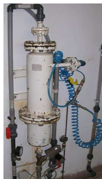
Figure 8 : Un hydrocyclone débouleur (station d'alerte du Vieux Rhône (69)).
