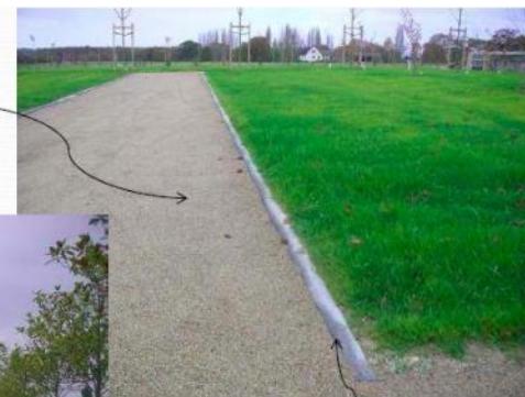
Bordure au niveau du sol, permettant un entretien plus facile.
