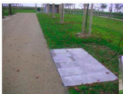
Un passage de tondeuse autour de l'assise facilite l'entretien
