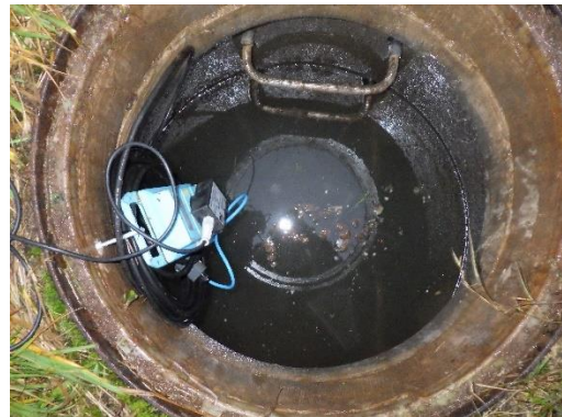
Mise en charge du réseau au droit du point de mesure n°3
