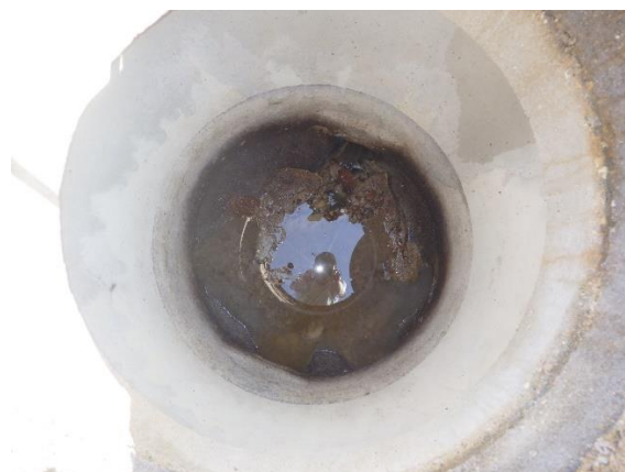
Présence de sable/ absence de cunette– Regard 36 – Allée du Clos des Champs
