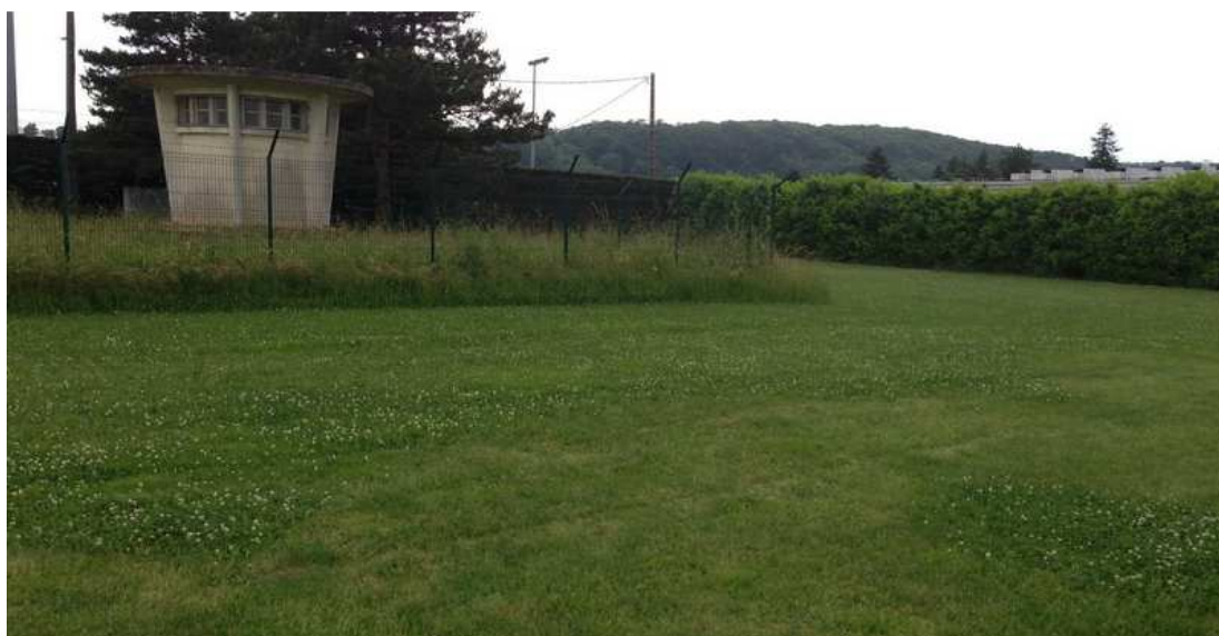
Figure 5 : Captage AEP d'Heyrieux
