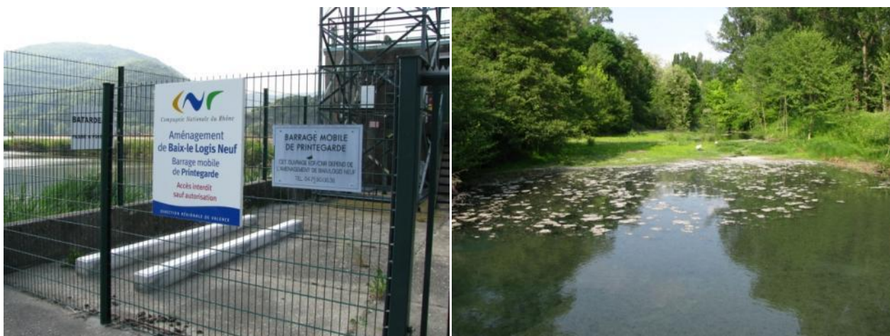
Barrage mobile / Lône du Petit-Rhône au pied du barrage mobile (12)
