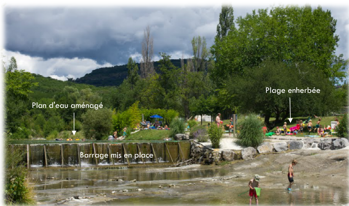
Photographie depuis l'aval du barrage en période estivale (Source : Google Maps)
