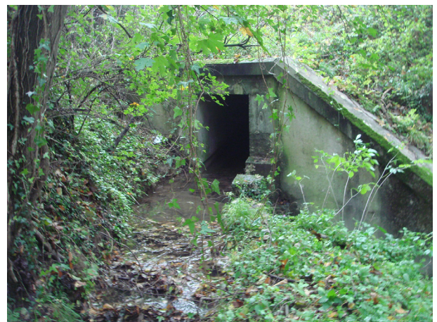
Canal de la Martinette - Site de mesure
