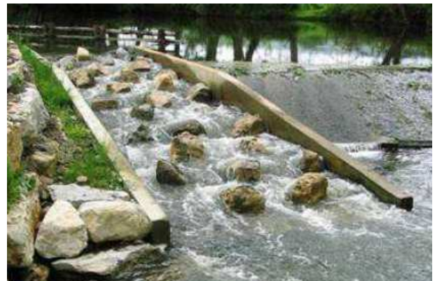
Rampe en enrochements
