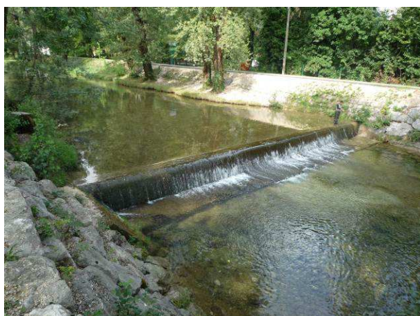
Exemple de seuil de stabilisation du profil en long sur le Furon
