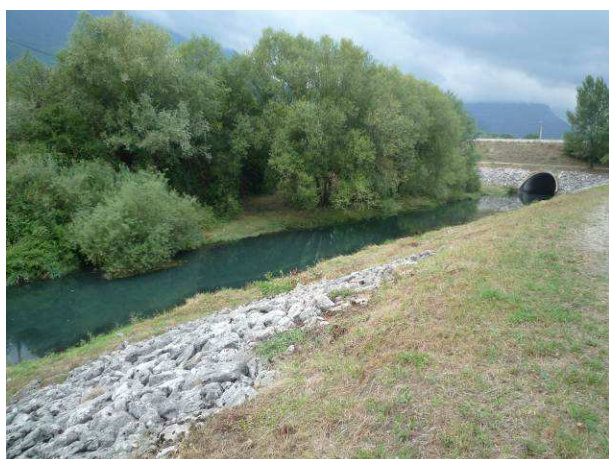
1. Risberme en rive gauche du Furon
