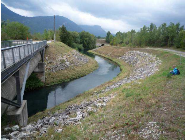
Le « canal du Furon » en amont de la station limnimétrique d'EDF
