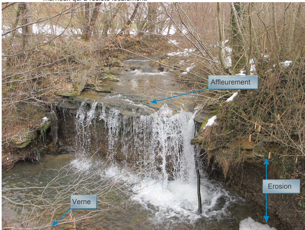
Vue du seuil (depuis l'aval)
