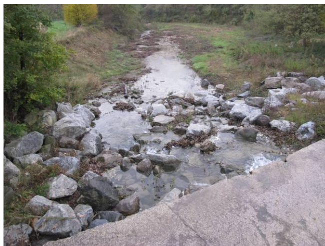
Vue du tronçon aval
