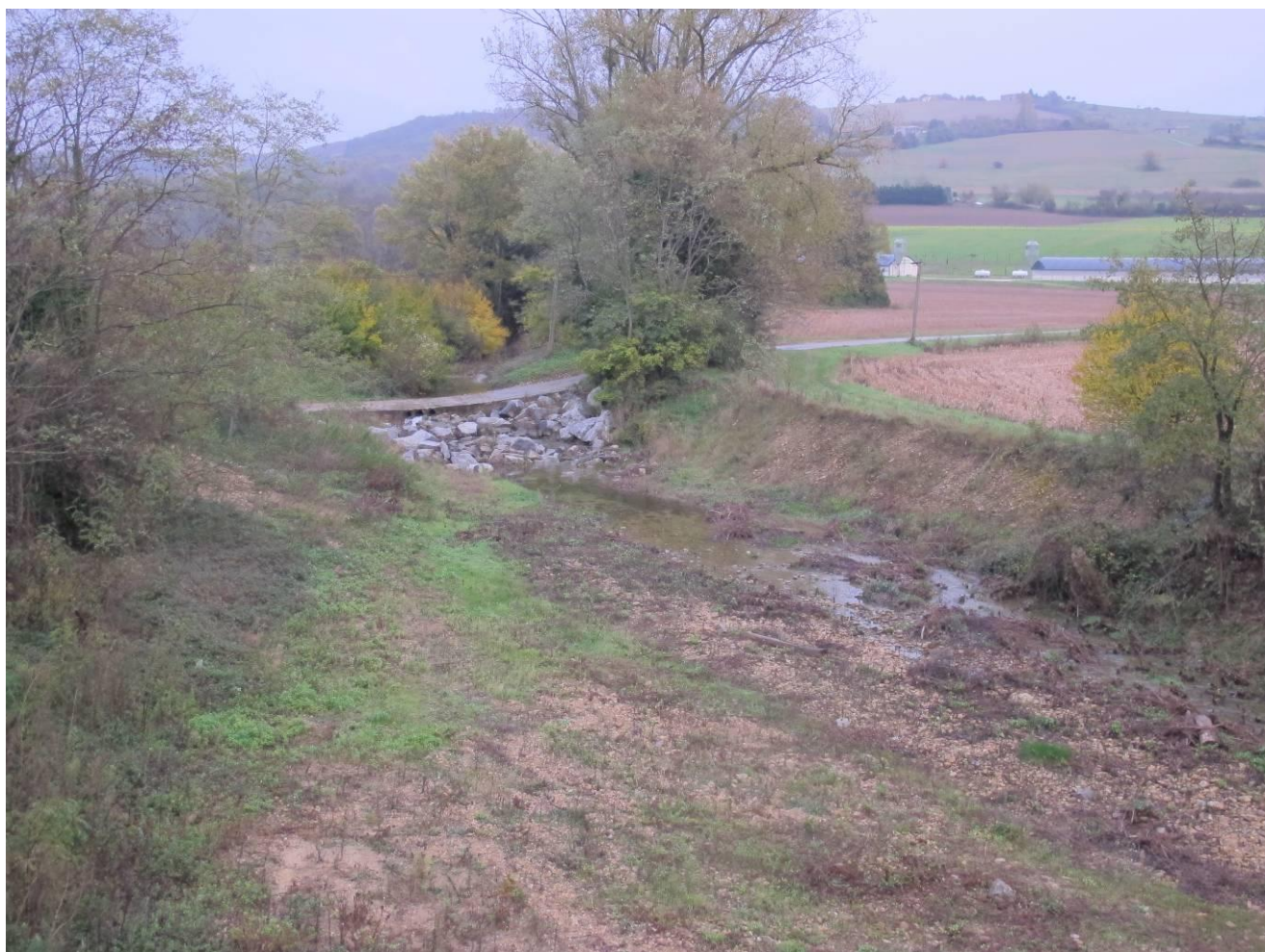
Vue depuis l'aval
