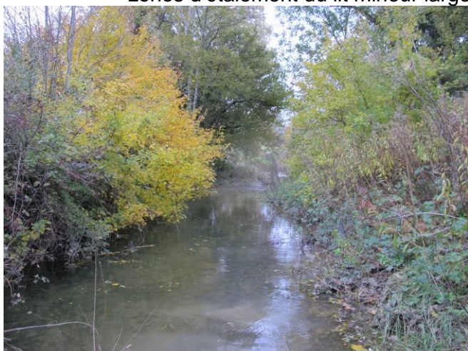
Vue du seuil
