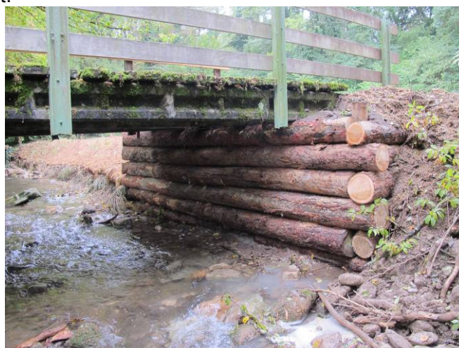
Culée protégée (après)
