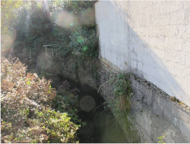
Vue du tronçon amont
