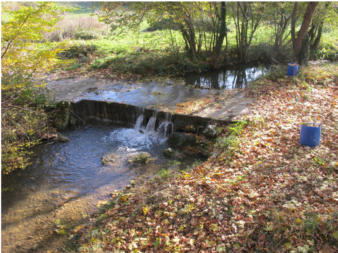
Vue depuis l'aval
