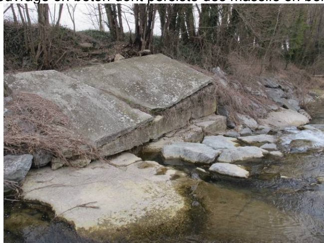
Vue des restes du seuil en béton
