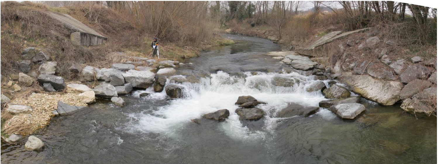
Vue depuis l'aval
