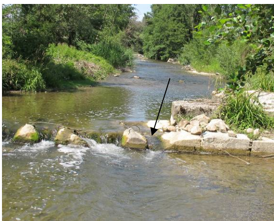
Chenal d'insertion de la passe à anguille à l'étiage
