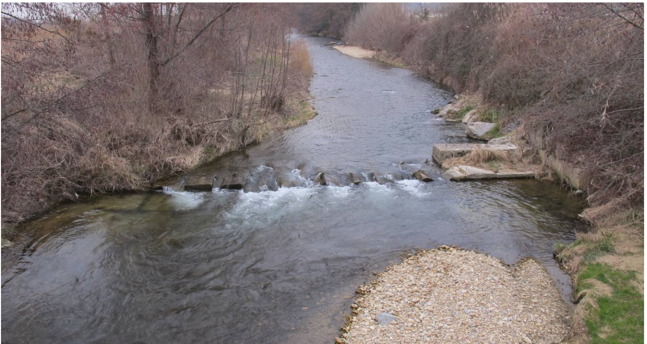
Vue depuis l'aval
