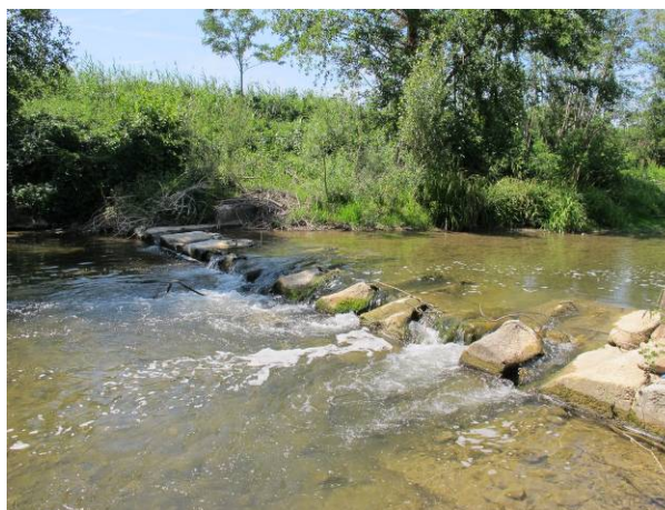
Vu des dalles béton (en étiage)
