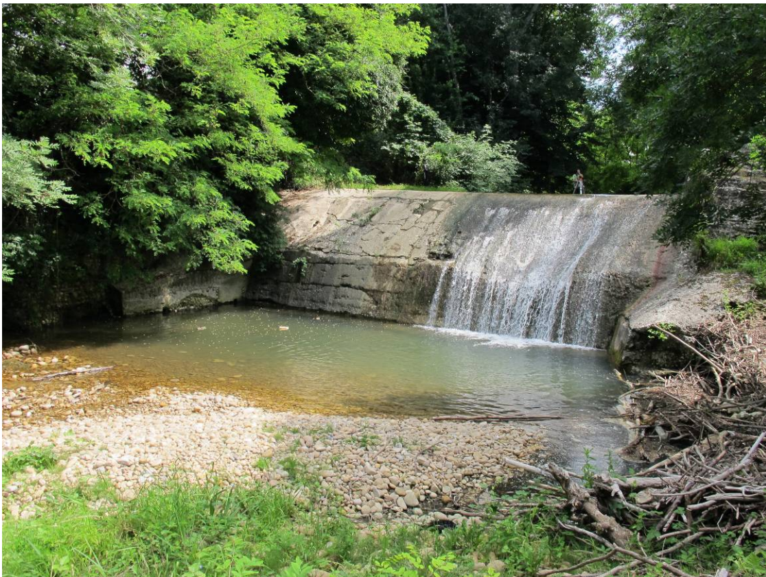
Vue depuis l'aval
