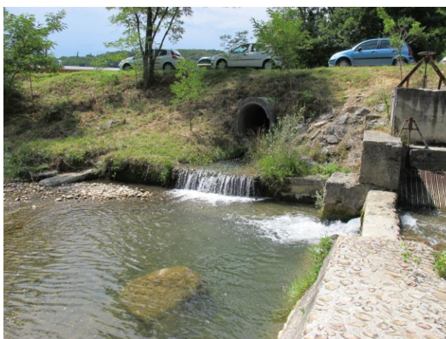
Vue de la confluence du Valet depuis le seuil
