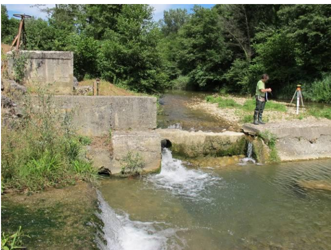
Vue de l'aval, du déversoir rive droite
