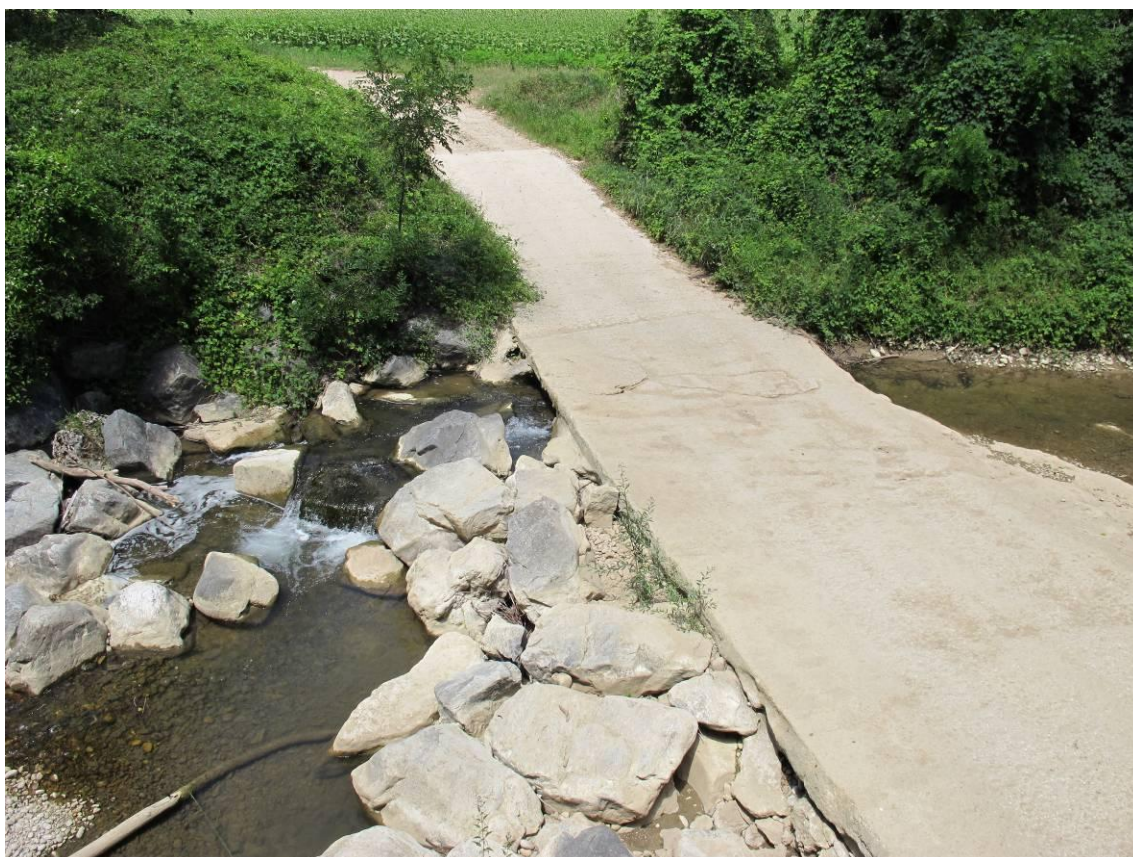
Vue depuis la rive gauche
