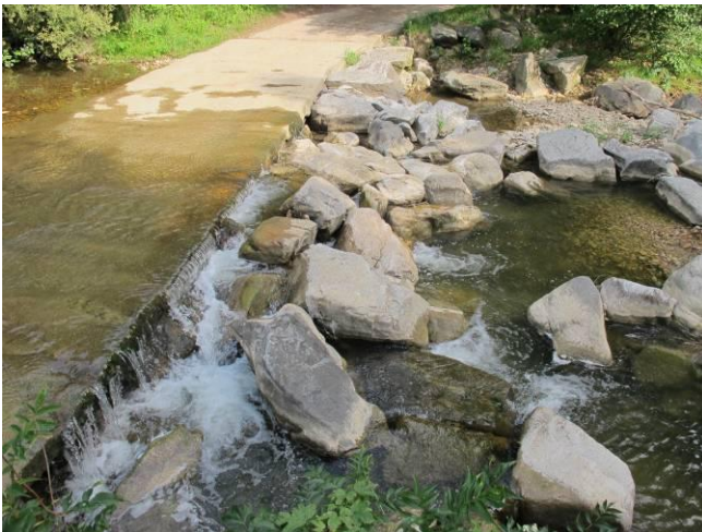
Vue des enrochements à l'aval
