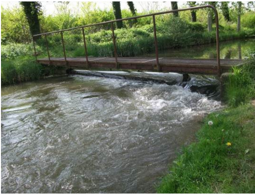
Ouvrage en aval de l'étang de pêche en dérivation du Cottey
