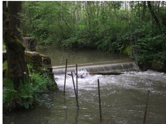
Ouvrage en aval des lacs des Pyes
