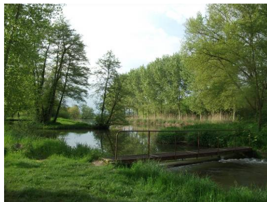
Ouvrage permettant la connexion entre le Cottey et le bras secondaire
