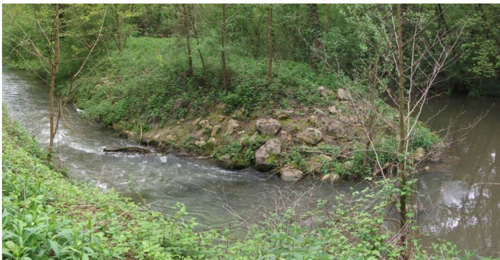
Rampe en enrochement permettant de reconnecter le Cottey à son lit originel
